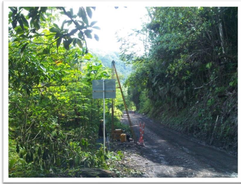
Fotografía 2 Zonas con procesos erosivos por lavado. (Fuente: Torres Ingeniería S.A.S)
