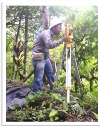
Fotografía 7 Localización delta Aux 28F. (Fuente: Torres Ingeniería S.A.S.)
