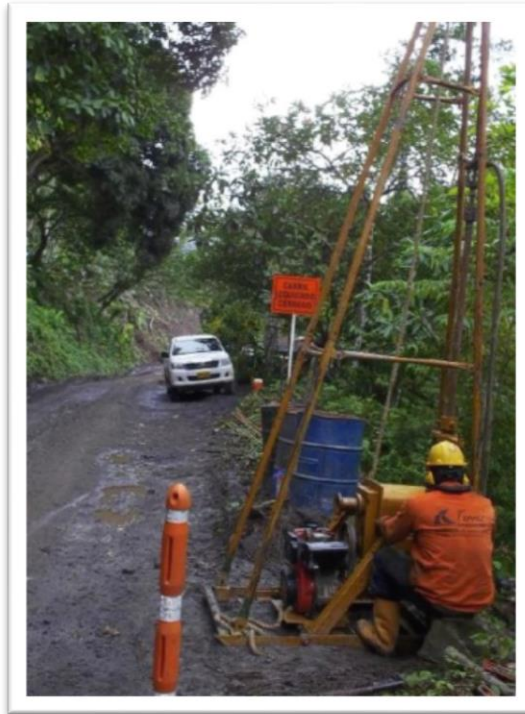
Fotografía 9 Vista del sondeo No. 1 realizado a roto percusión. (Fuente: Torres Ingeniería S.A.S.)
