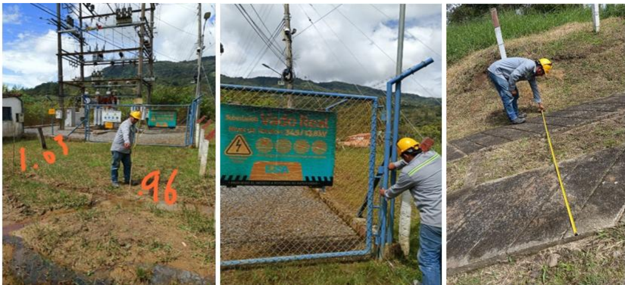
Figura 7 Toma de medidas insitu en la Subestación Vado Real
