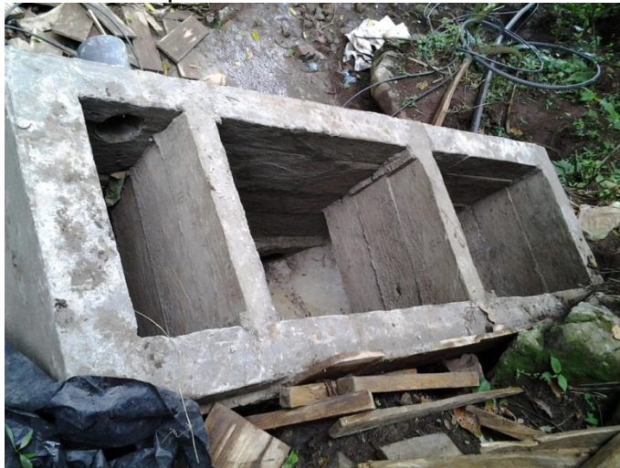
Figura 165. Desarenador de placas deflectoras en concreto reforzado
