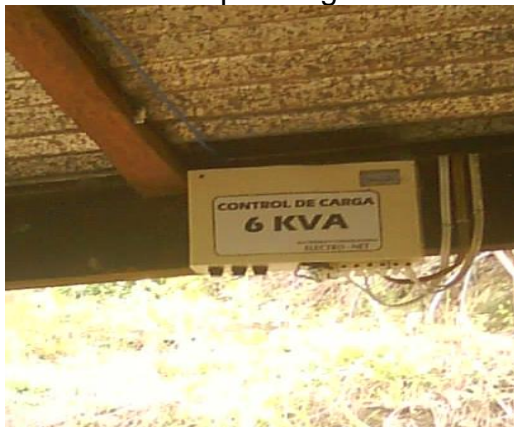
Figura 121. Regulador de frecuencia por carga
