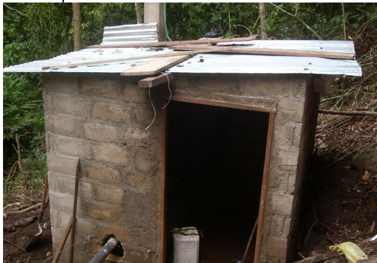
Figura 174. Casa maquinas terminada
