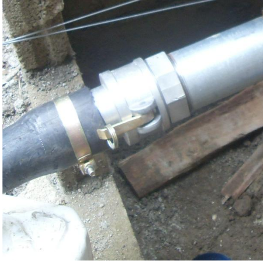
Figura 169. Uniones con abrazaderas
