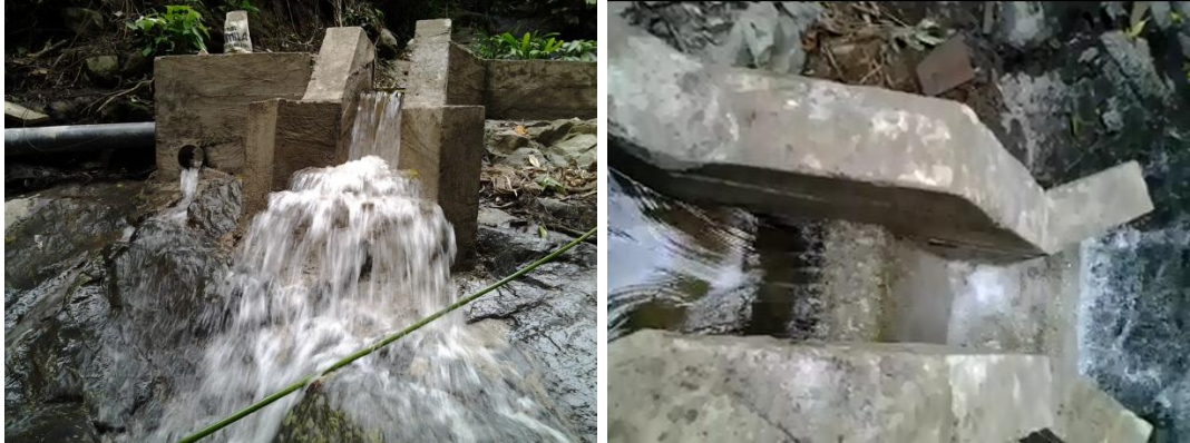
Figura 194. Resalto o colchón amortiguador
