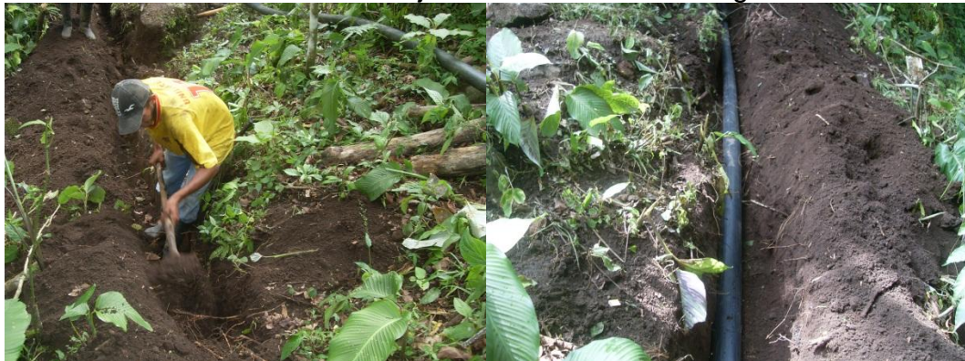
Figura 168. Construcción de la zanja de instalación de manguera
