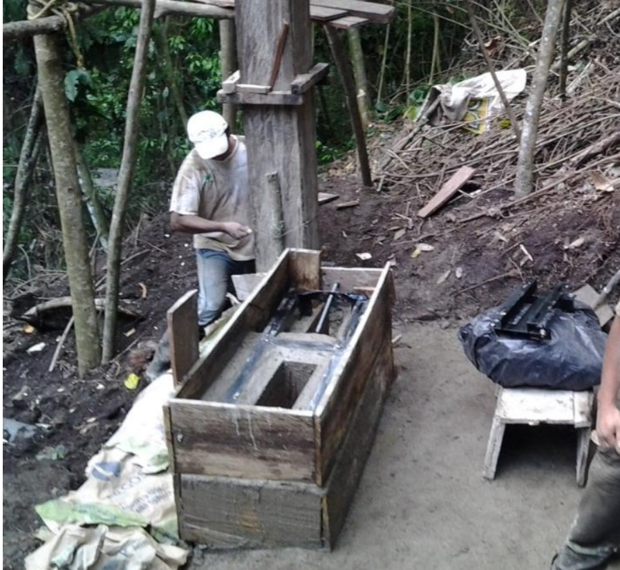
Figura 172. Fundición del muro de soporte de la turbina
