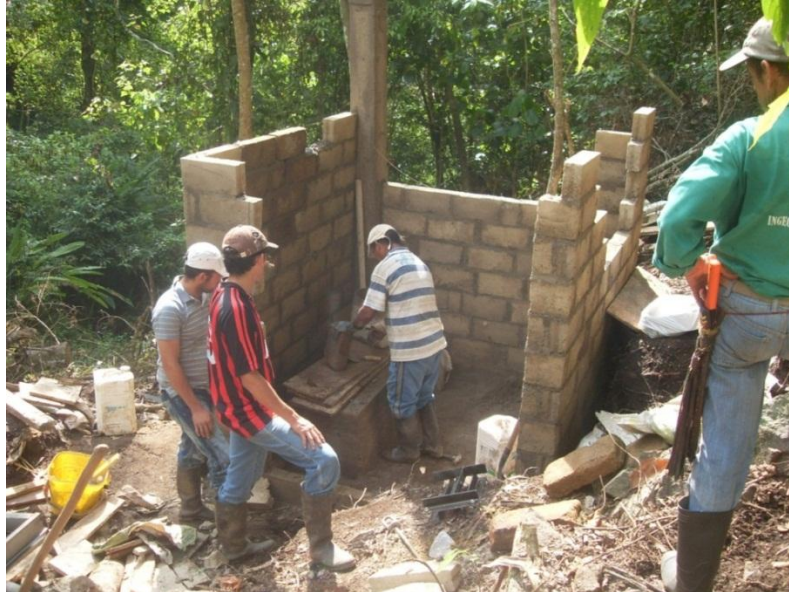
Figura 173. Levantamiento de paredes de la casa máquina
