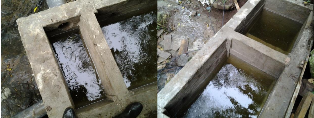
Figura 196. Cámaras del desarenador
