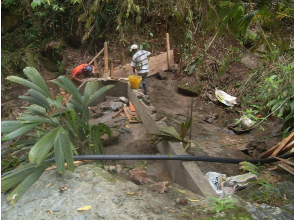
Figura 163. Cimientos y estructura armada en madera de muros bocatoma
