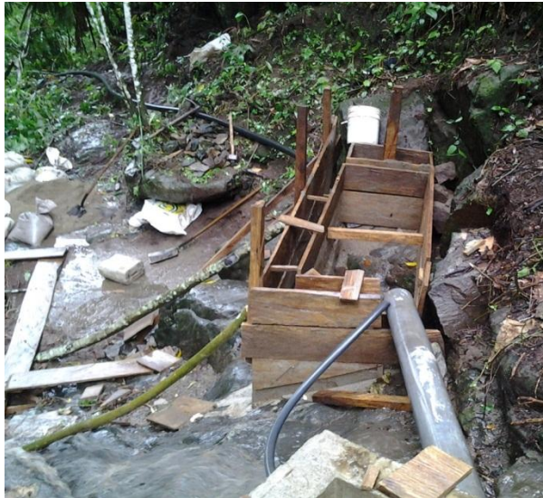
Figura 162. Estructura armada en madera del desarenador
