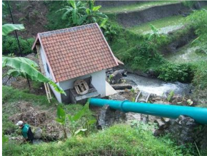
Figura 11. Casa Maquinas Microcentral en Trawas distrito de Mojokerto
