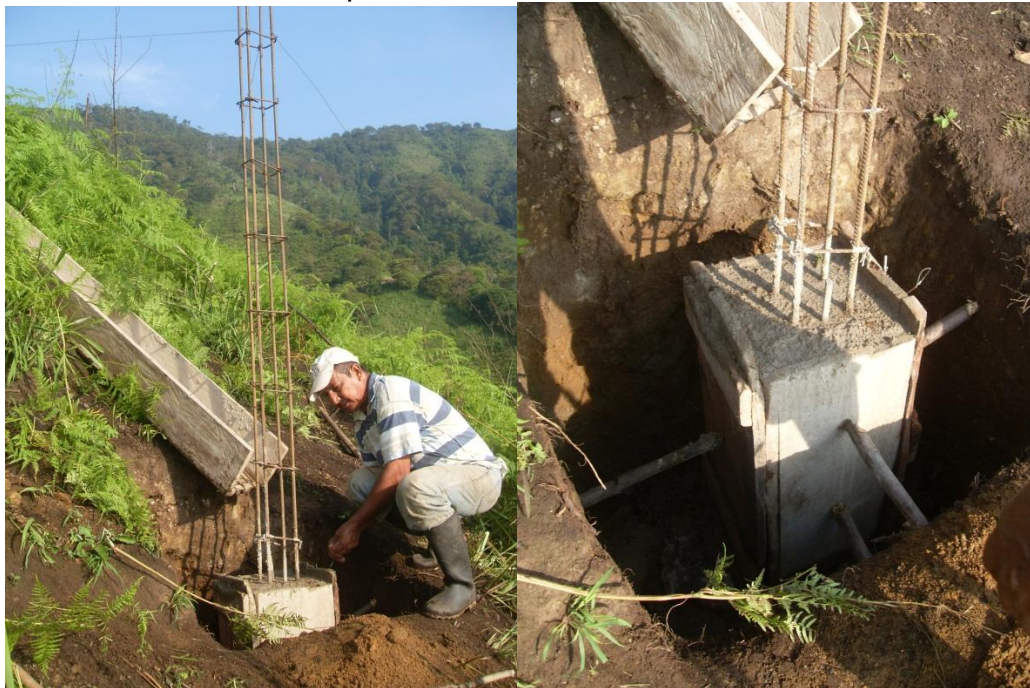
Figura 175. Pedestal de los postes armados en sitio
