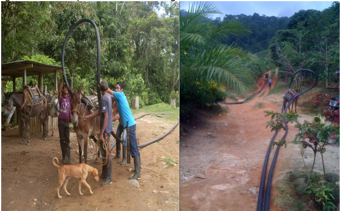
Figura 166. Transporte de rollos de manguera de 3" de HDPE.
