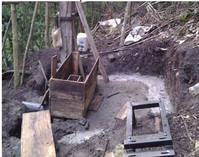
Figura 171. Cimientos de casa maquina
