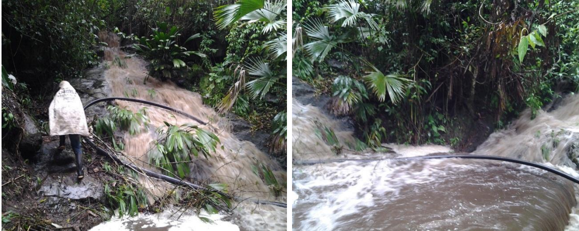
Figura 195. Creciente Soportada por las obras de captación
