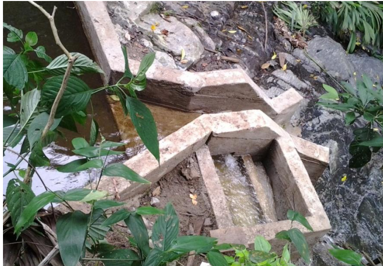
Figura 193. Cámara de excesos
