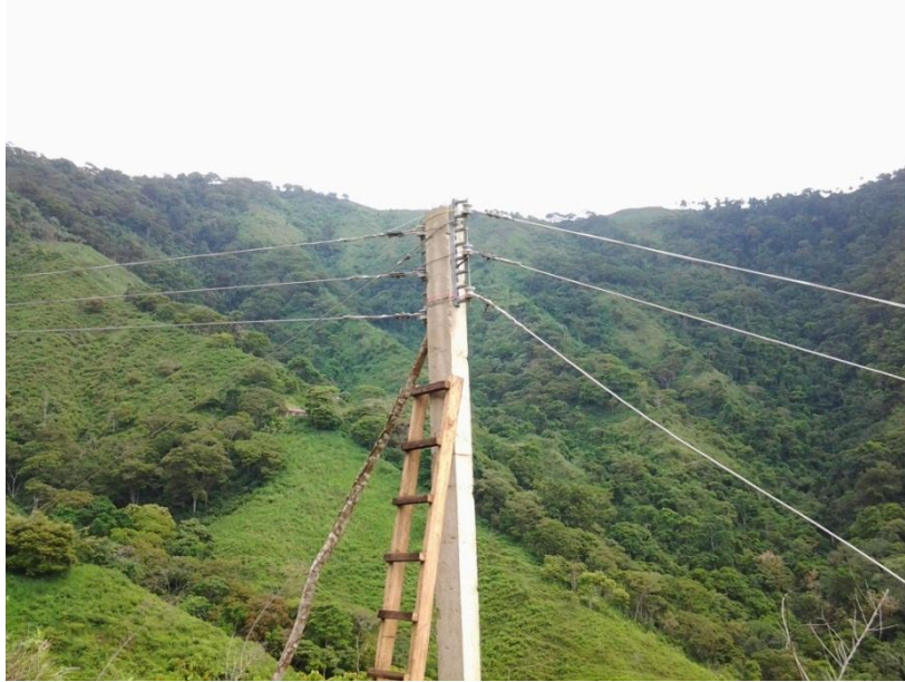
Figura 178. Instalación de redes en postes
