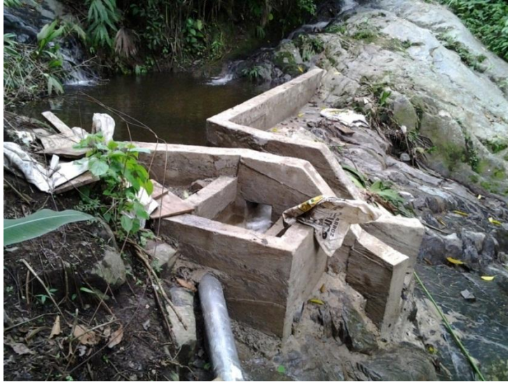
Figura 164. Bocatoma de fondo en concreto reforzado
