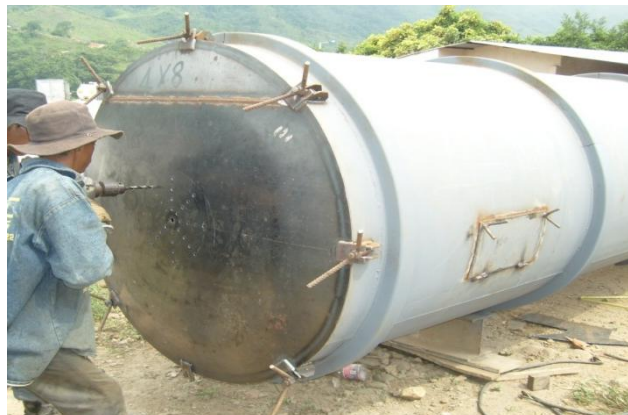
Figura 73. Taladrado de los agujeros de la tapa de descarga.
