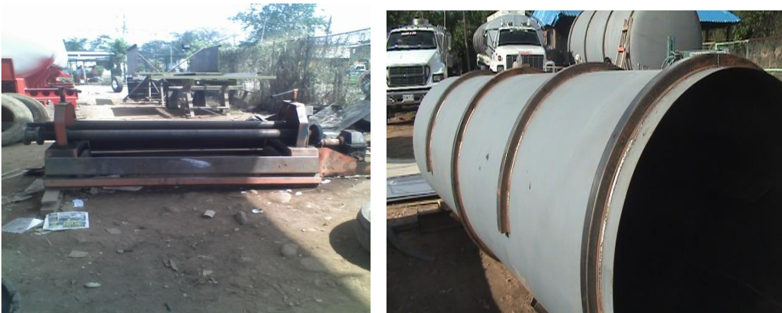
Figura 68. Maquina cilindradora y Envolverte del tanque con presentación de anillos.
