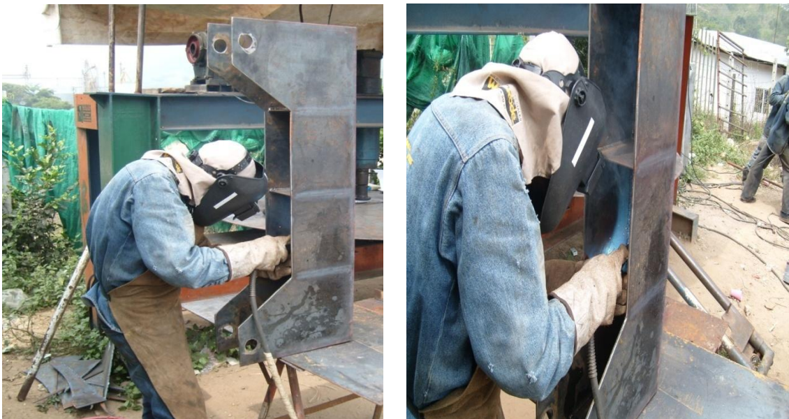
Figura 80. Soldadura de refuerzos en las bases del bastidor con equipo MIG.
