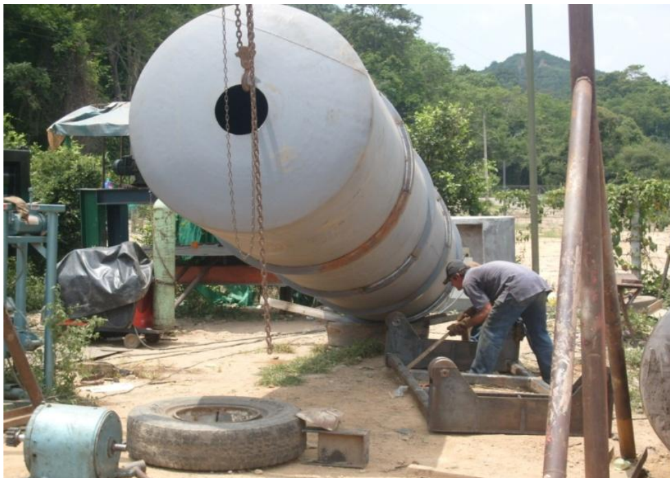
Figura 84. Elevación del tanque por medio del polipasto.
