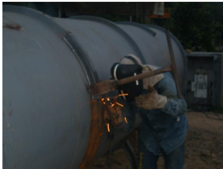
Figura 76. Tensor de tornillo para asegurara asentamiento de anillo sobre periferia del tanque.
