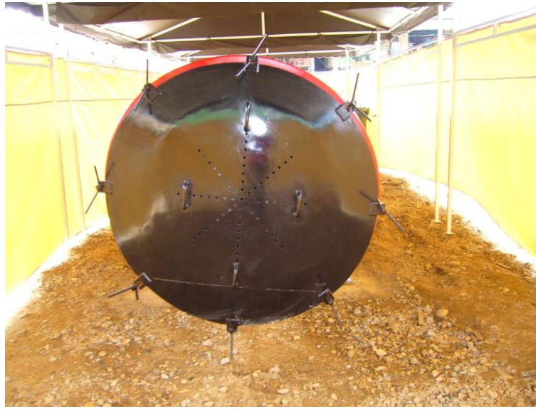
Figura 93. Tanque instalado visto desde la compuerta de descarga.
