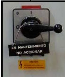
Figura 58. Señalización de puntos remotos de conexión.
