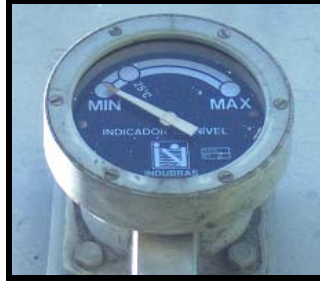
Figura 18. Indicador de nivel de aceite tipo magnético.
