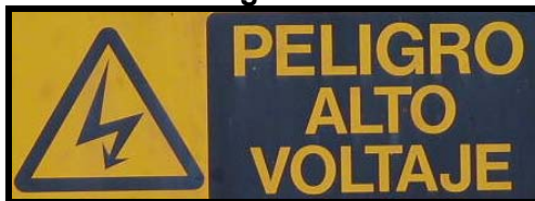
Figura 57. Señalización reglamentaria en Subestaciones.
