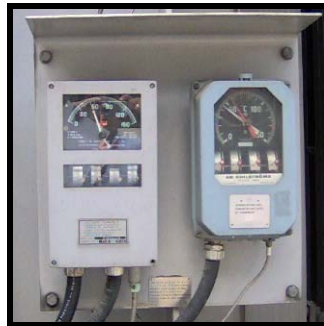
Figura 8. Termómetros de los devanados y del aceite.
