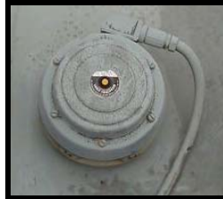
Figura 12. Válvula de sobrepresión
