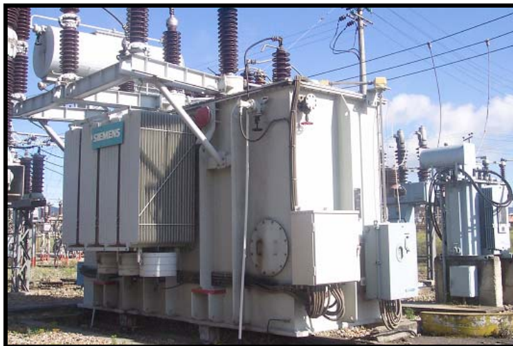
Figura 5. Transformador 30-40 MVA.
