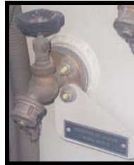
Figura 6. Válvula para toma de muestras de aceite.
