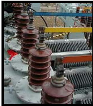
Figura 7. Pasatapas de media tensión (34.5 kV).
