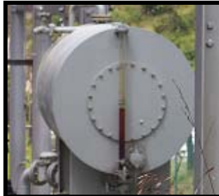
Figura 19. Indicador de nivel de aceite tipo visor.
