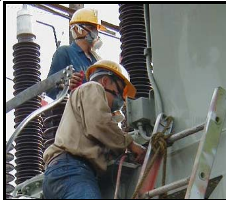
Figura 32. Pintura de transformadores.
