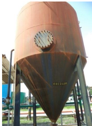
Figura 40. Tanque Trompo 500 Bbls PES
