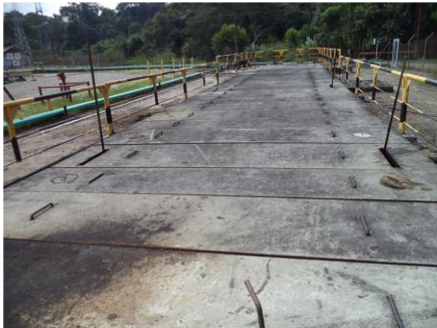
Figura 14. Skimmer - Separador API
