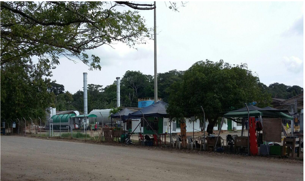
Anexo M. Foto Vista desde afuera del Módulo 1
