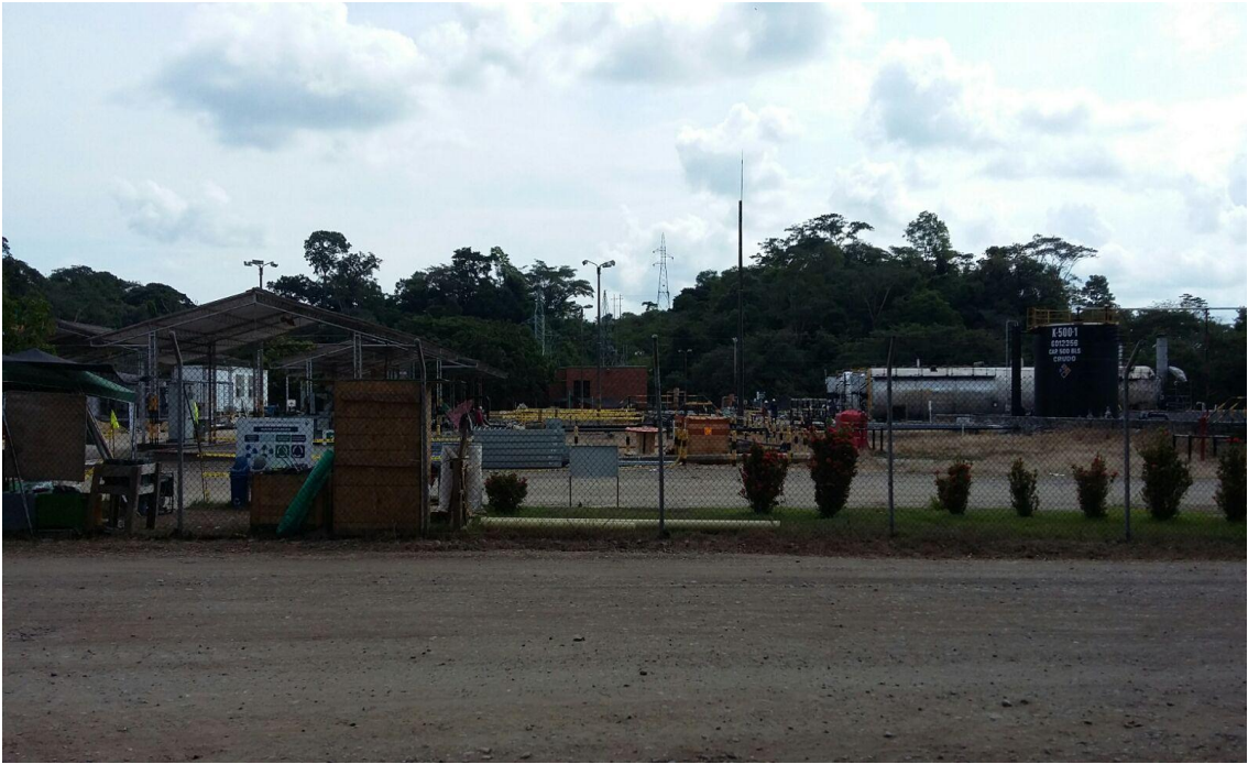
Anexo J. Foto Vía de acceso al Módulo 1
