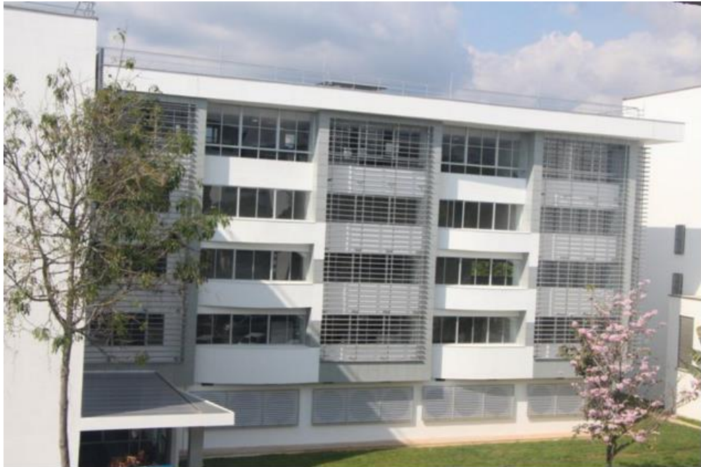
Figura 3. Fachada Edificio Eléctrica (Tomado de la página web de la universidad)
