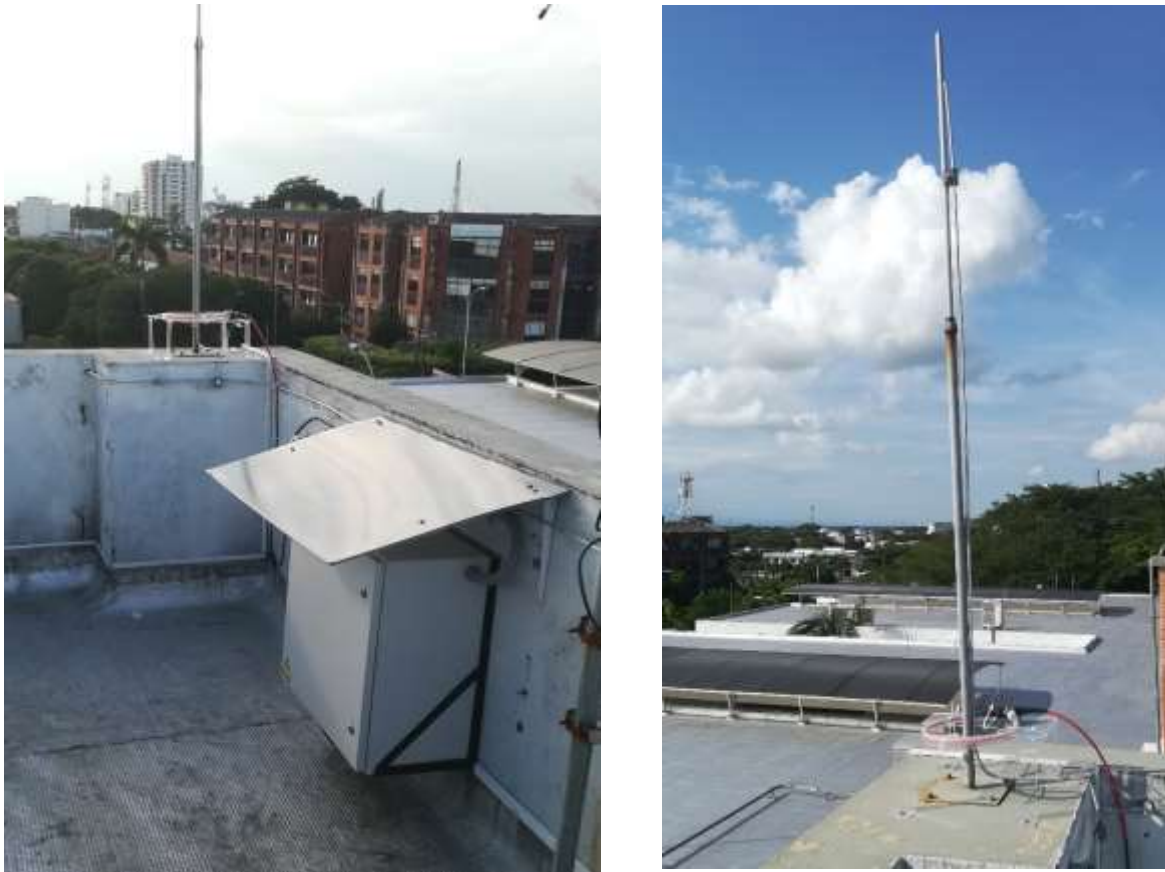
Figura 7. Vista final de instalación del equipo en la terraza de la sede UIS, Barrancabermeja.
