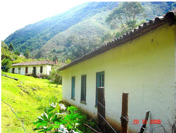
Foto 17. Las casas aún están en pie, al fondo casa habitada.
