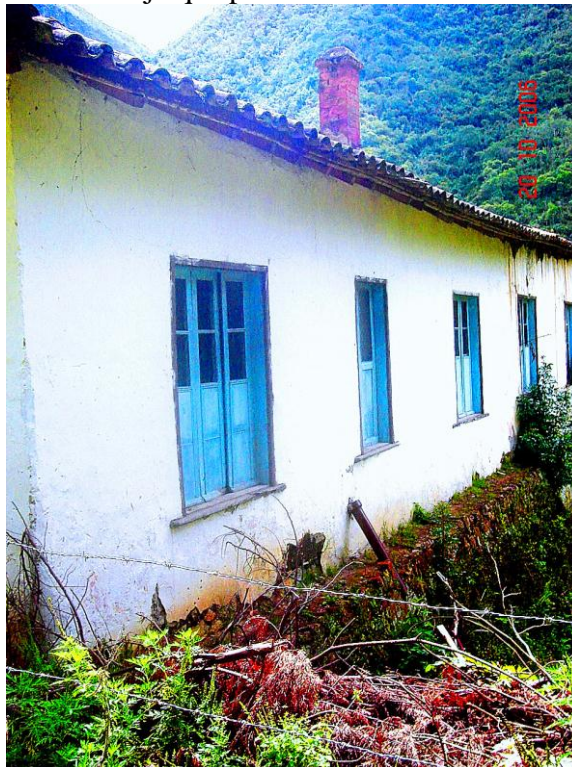
Foto 24. Fachada casona de trabajo que perteneció a la Francia Gold and Silver Company.
