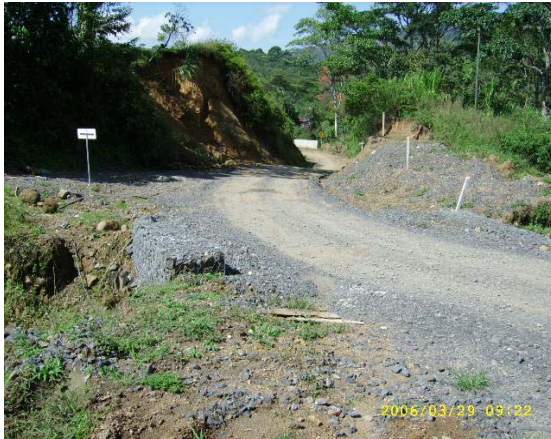
Figura 33. Estado inicial de la vía
