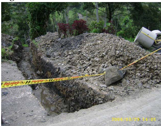
Figura 19. Excavación Alcantarillas
