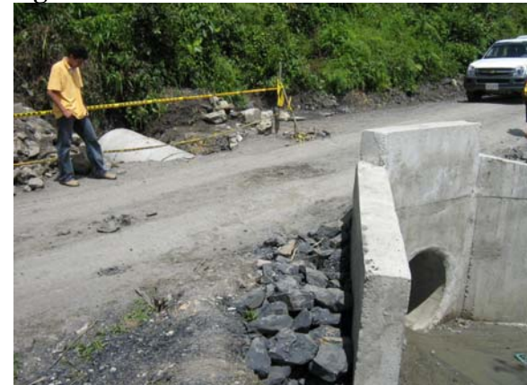
Figura 20. Construcción de Alcantarillas
