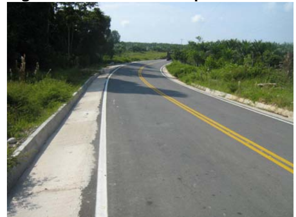
Figura 58. Detalle sector pavimentado
