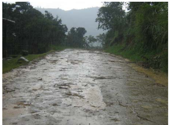
Figura 50. Intensas lluvias en la vía
