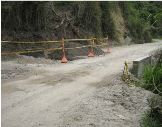
Figura 89. Construcción de alcantarillas. Figura 90. Compactación de Material de Subbase.
