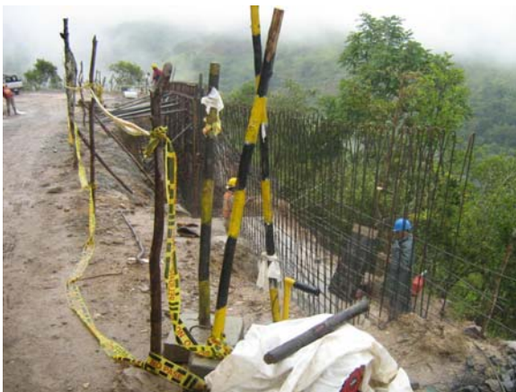
Figura 49. Construcción Muro de Contención
