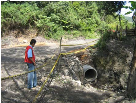
Figura 27. Construcción Alcantarillas
