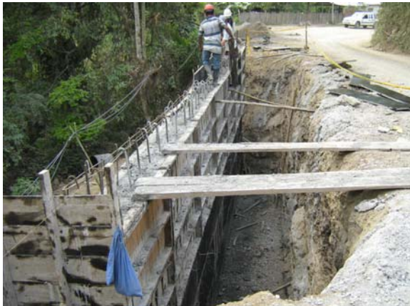
Figura 95. Construcción de Muros
