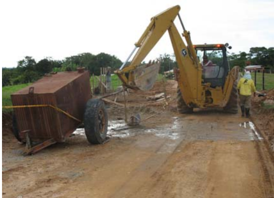
Figura 61. Excavaciones obras de Drenaje.
