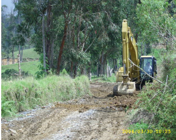
Figura 13. Mejoramiento de subrasante
