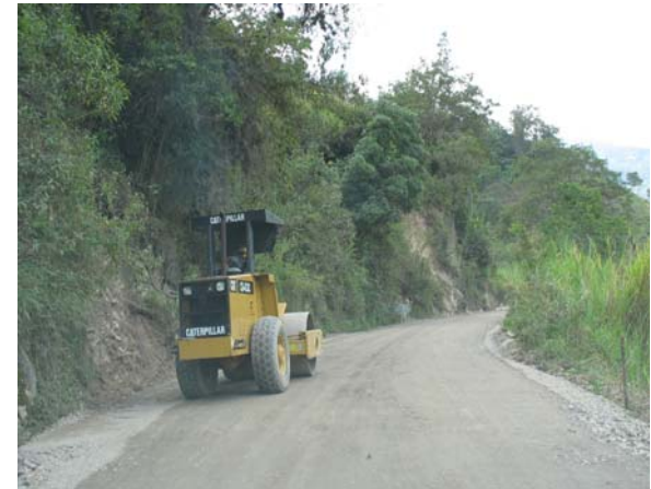
Figura 89. Construcción de alcantarillas. Figura 90. Compactación de Material de Subbase.
