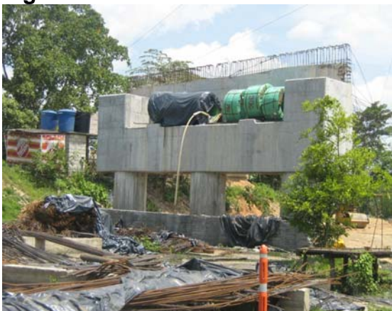
Figura 101. Detalle de estribos
