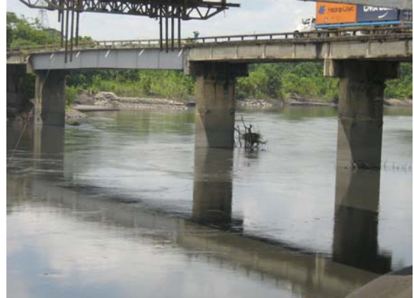
Figura 104. Detalle puente existente
