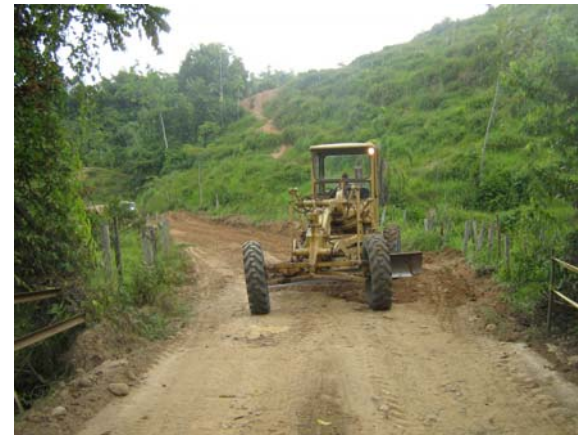
Figura 68. Extendida de material
