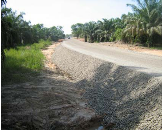
Figura 53. Espesor material granular
