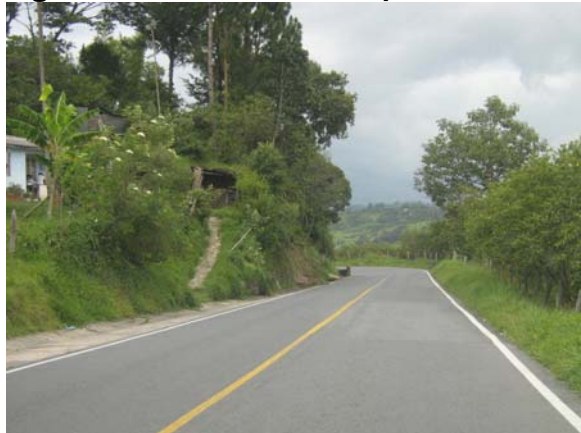
Figura 108.. Detalle tramo pavimentado
