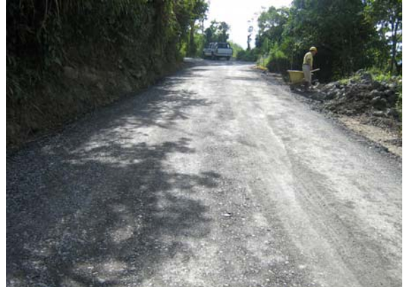
Figura 36. Compactación de base
