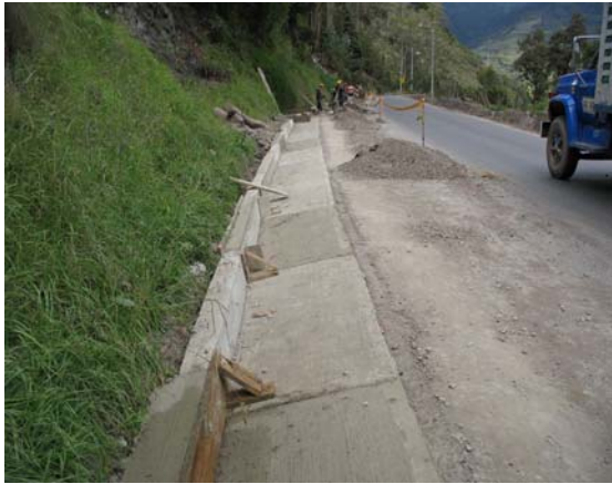
Figura 129. Construcción de Cunetas.
