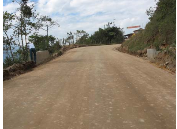
Figura 46. Construcción de Alcantarillas
