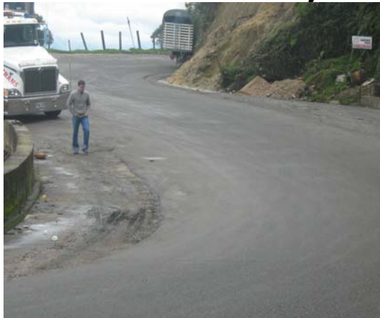
Figura 120. Terminación Obras de Drenaje sector La Nevera
