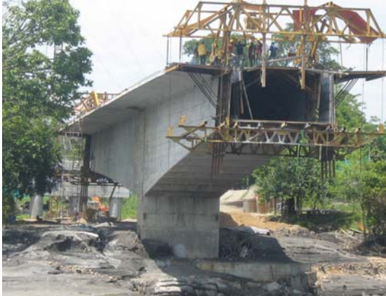
Figura 103. Construcción de voladizos
