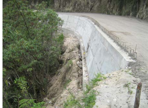
Figura 88. Muro de Contención.
