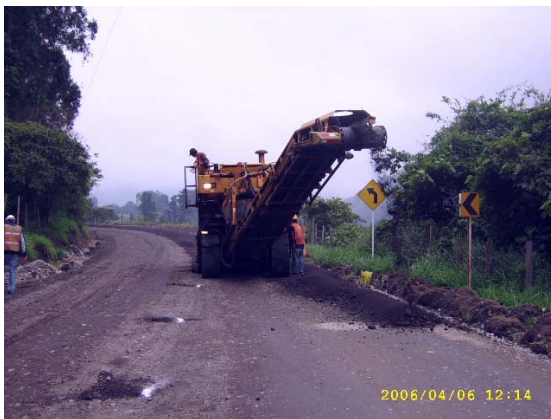
Figura 127. Reciclaje de pavimento.
