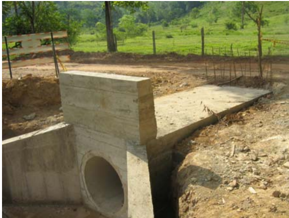
Figura 69. Construcción de Alcantarillas Figura 70. Instalación planta de trituración
