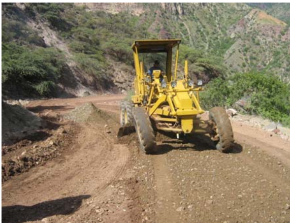
Figura 83. Extendida material de Subbase.
