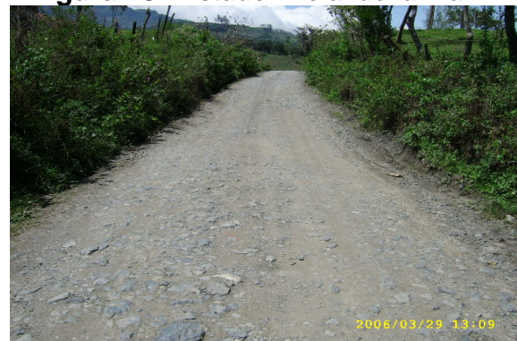
Figura 18. Estado inicial de la Vía
