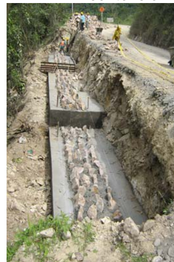
Figura 86. Construcción muro de contención.
