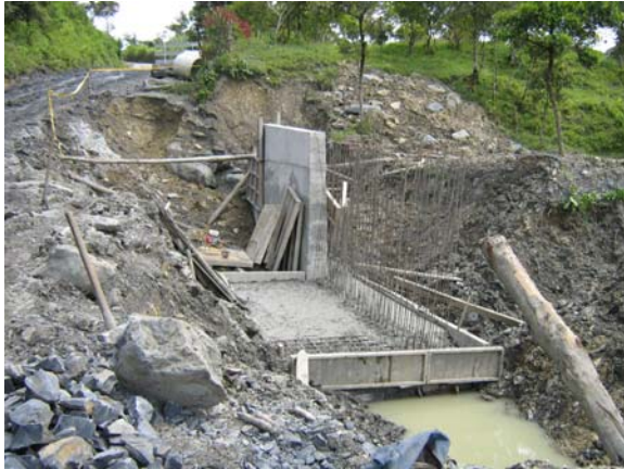
Figura 21. Muro de Contención) (K4+970
