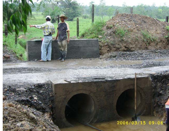
Figura 8. Obras de Drenaje
