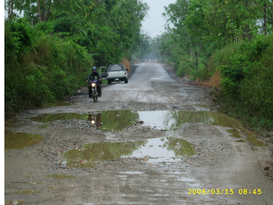
Figura 6. Estado inicial de la vía
