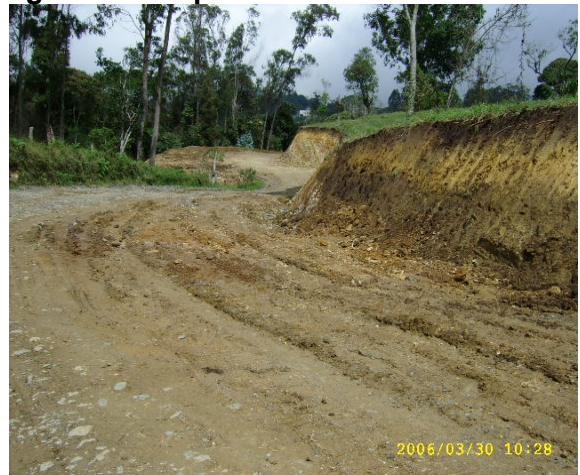
Figura 12. Ampliación de la banca
