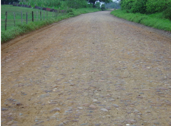
Figura 5. Estado inicial de la vía.
