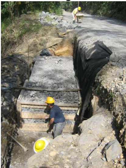
Figura 37. Construcción muro. en gaviones
