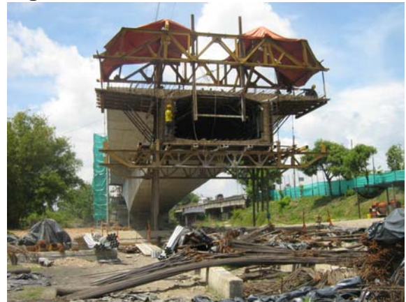
Figura 100. Construcción de Voladizo
