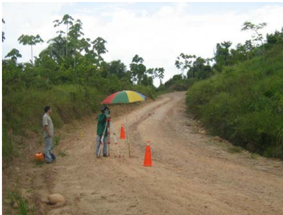
Figura 67. Localización y replanteo
