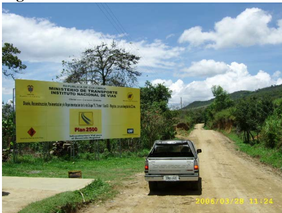
Figura 43. Estado Inicial de la Vía
