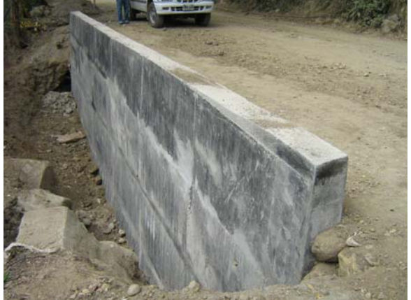
Figura 96. Muro de Contención
