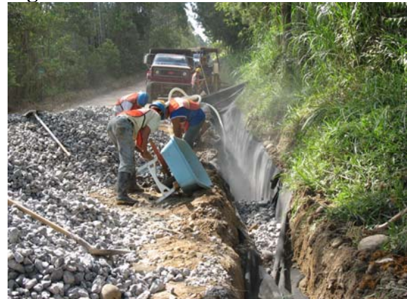
Figura 44. Construcción de filtros
