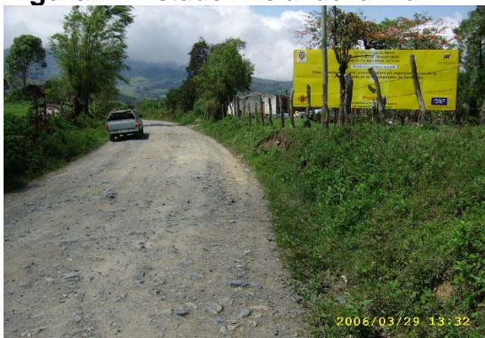
Figura 17. Estado inicial de la Vía
