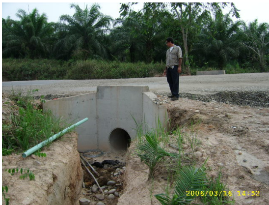
Figura 51. Construcción de Alcantarillas base
