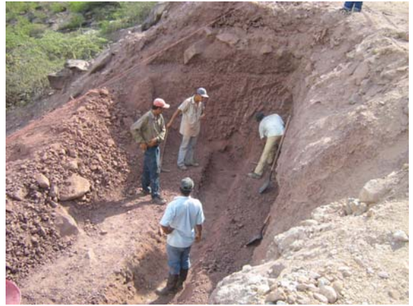
Figura 80. Excavación para construcción de muro
