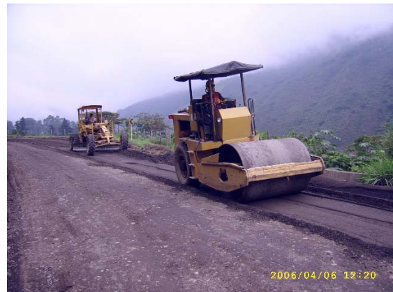
Figura 128. Extendida y compactación
