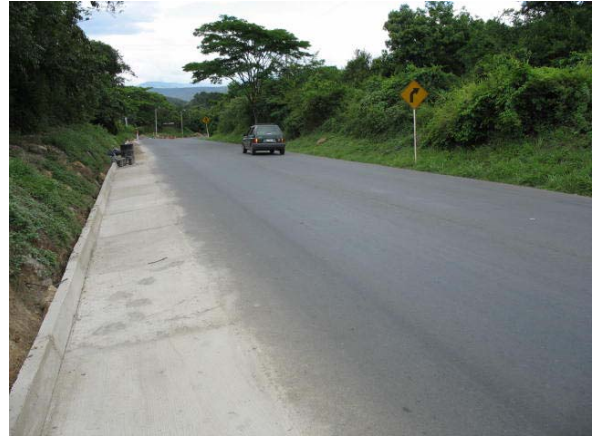
Figura 130. Detalle tramo pavimentado
