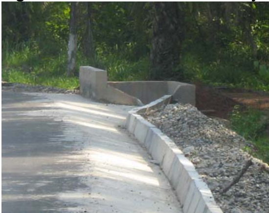
Figura 57. Detalle Obras de Drenaje
