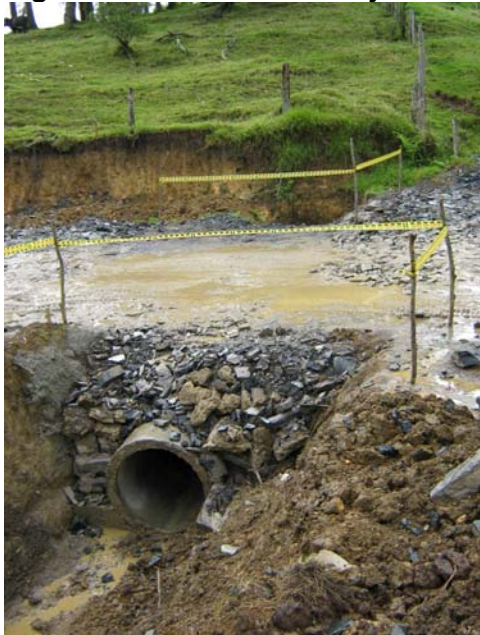
Figura 15. Obras de Drenaje
