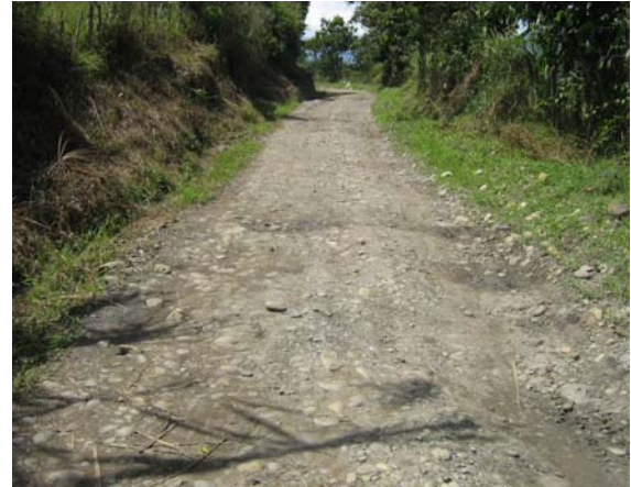
Figura 32. Trabajos de rocería y limpieza
