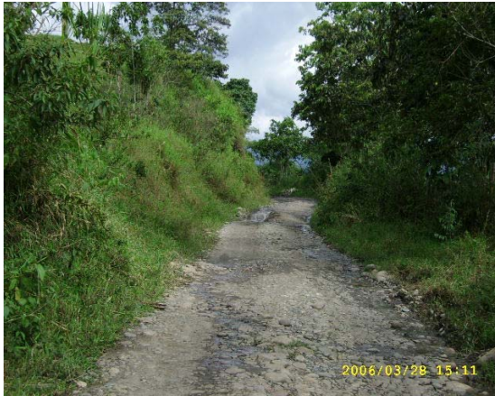
Figura 31. Estado inicial de la Vía (K12+100)
