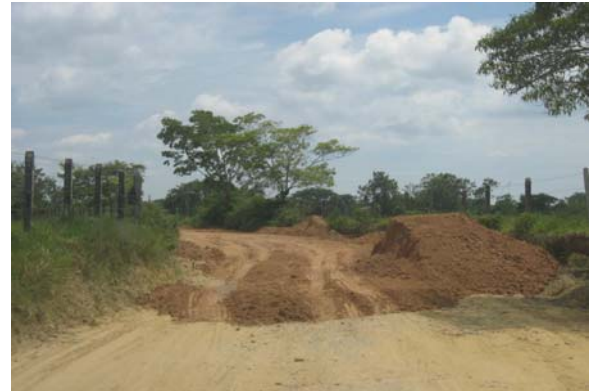
Figura 62. Extendida material de Subbase.
