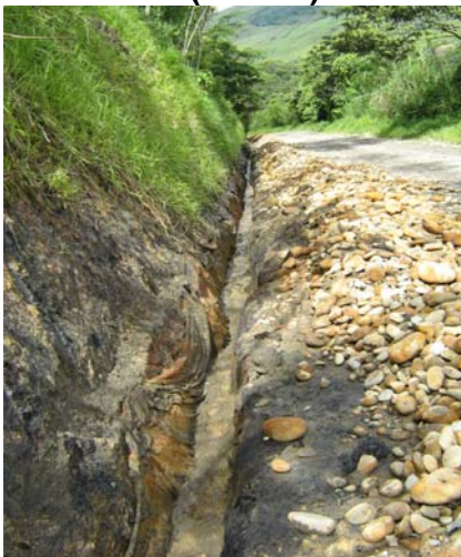
Figura 25. Construcción de filtros (k7+800)
