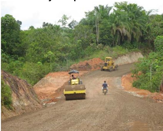
Figura 55. Extendida material de base y compactación
