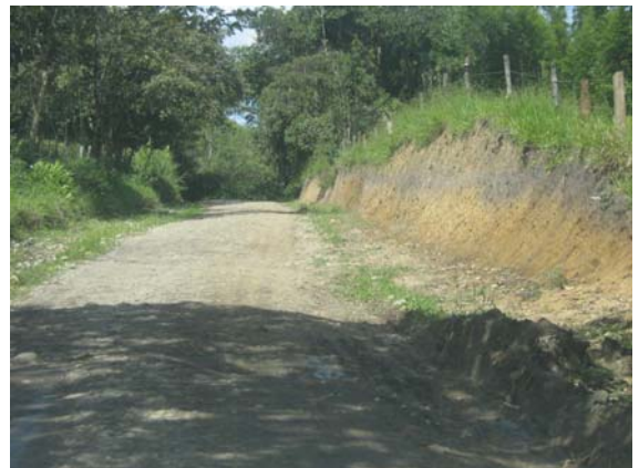
Figura 28. Ampliación de la banca.
