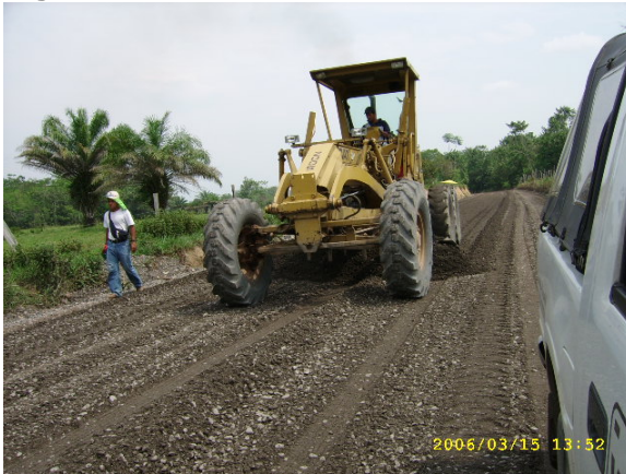
Figura 7. Extendida material de base.
