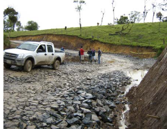
Figura 14. Extendida de “Rajón”
