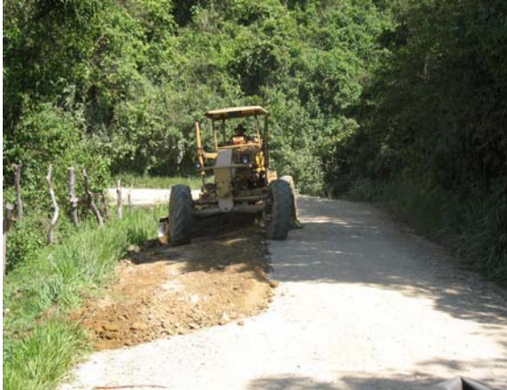
Figura 45. Recuperación de subrasante
