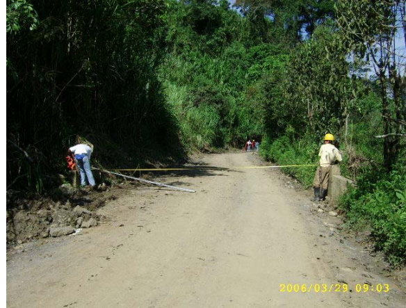
Figura 34. Localización y Replanteo.
