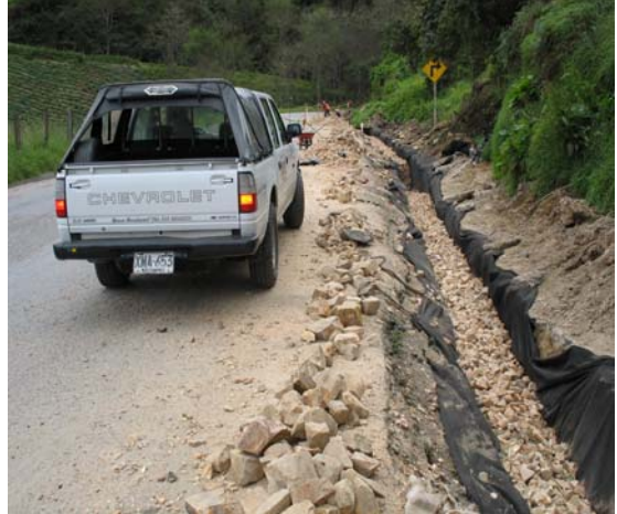
Figura 126. Construcción de filtros
