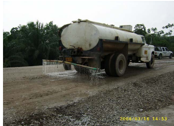
Figura 52. Riego de agua para compactación de la
