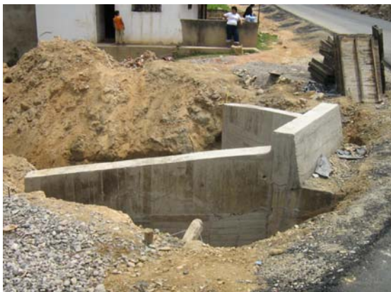
Figura 73. Construcción de alcantarillas (Km 3 + 600).
