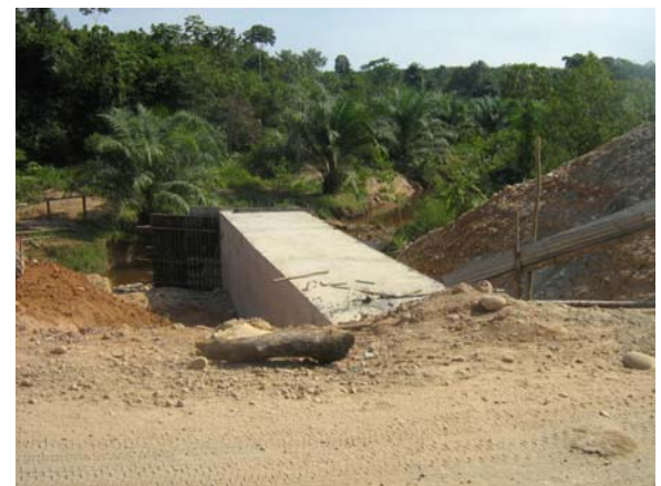
Figura 56. Construcción de Box Coulvert
