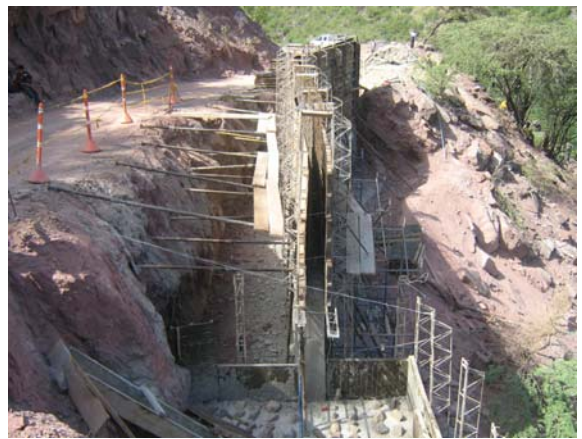
Figura 82. Construcción muro de Contención
