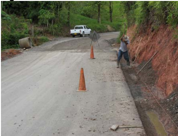
Figura 9. Construcción de cunetas
