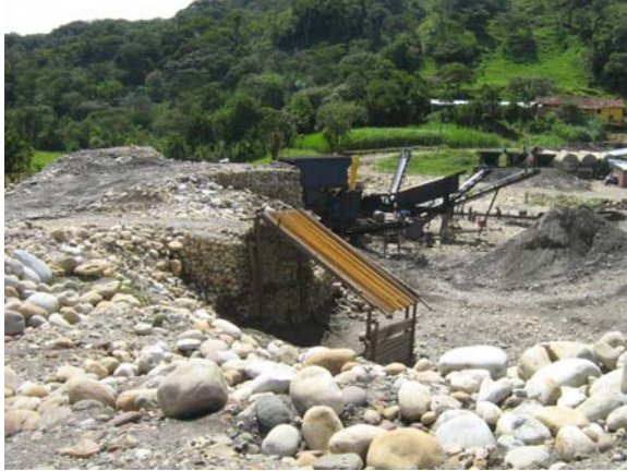
Figura 29. Montaje planta trituración y acopio
