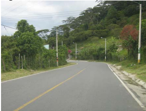
Figura 107. Detalle tramo pavimentado
