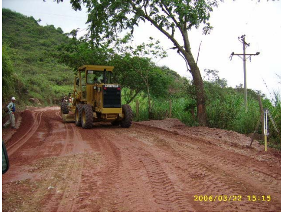
Figura 71. Ceréo de la rasante (Km 2 + 850)
