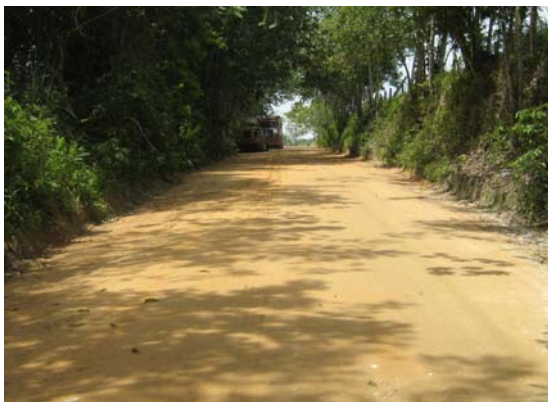
Figura 63. Vía con material de subbase
