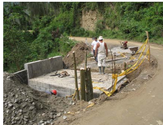
Figura 92. Construcción Obras de Drenaje.
