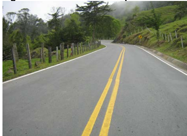
Figura 113. Detalle Tramo pavimentado
