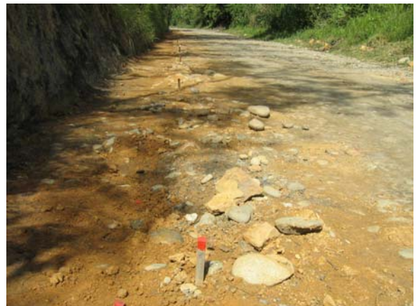
Figura 28. Ampliación de la banca.
