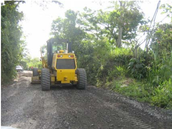
Figura 35. Extendida material de base
