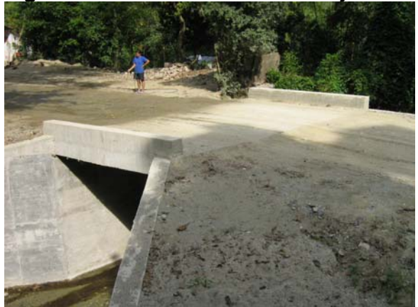
Figura 98. Detalle obras de drenaje
