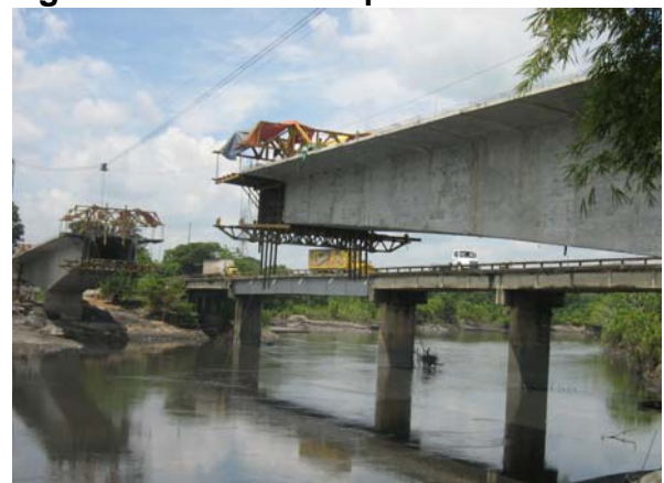
Figura 102. Detalle empalme de voladizos
