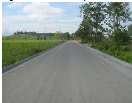
Figura 10. Detalle tramo pavimentado
