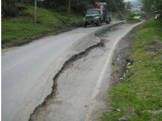
Figura 105. Hundimiento en la banca
