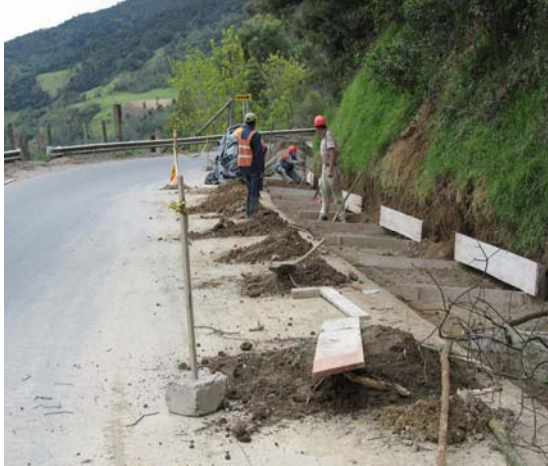
Figura 125. Construcción de cunetas
