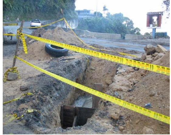
Figura 119. Obras de Drenaje
