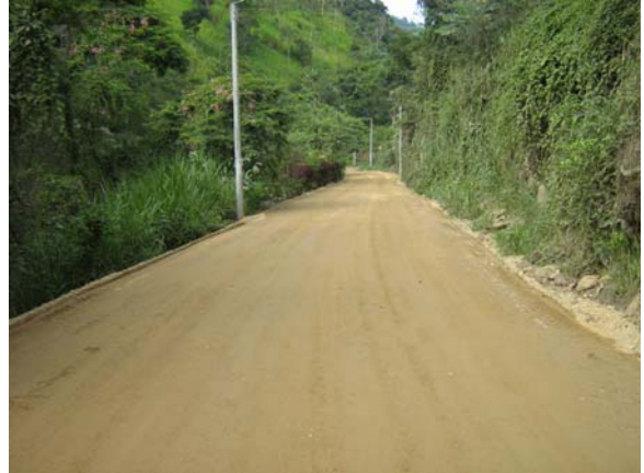
Figura 94. Material de Subbase instalado y compactado
