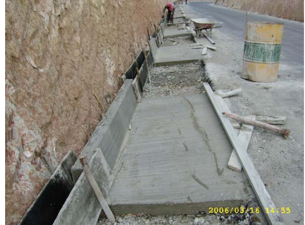
Figura 54. Construcción berma-cunetas
