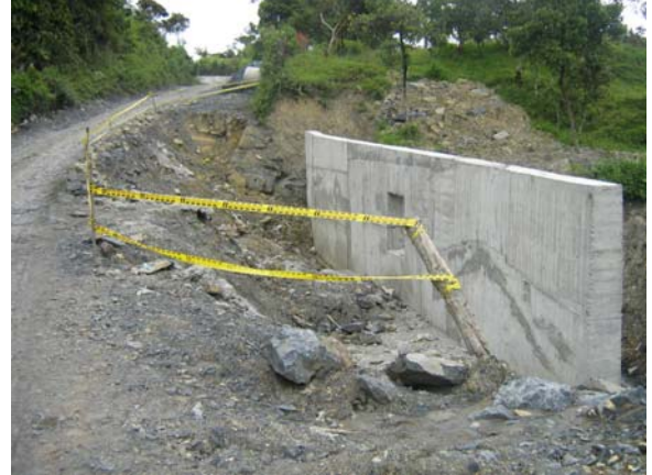
Figura 22. Muro terminado K4+970
