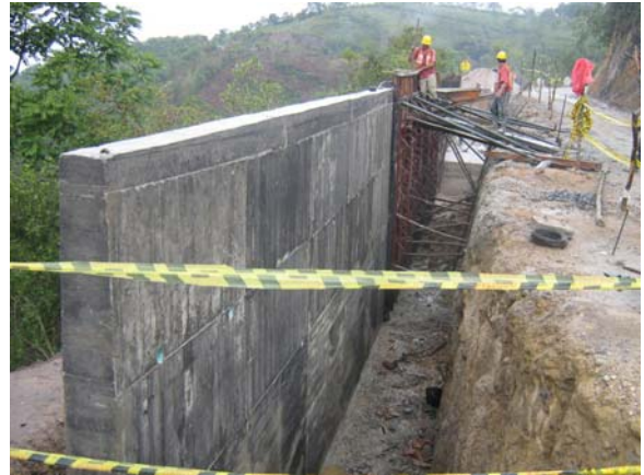
Figura 48. Construcción Muro de Contención
