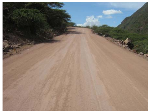
Figura 84. Vía con material granular
