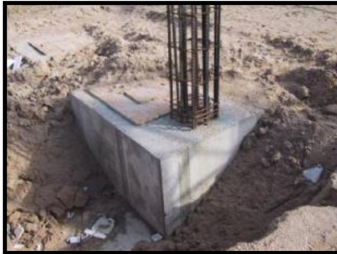
Figura 3: Cimentación aislada rectangular
