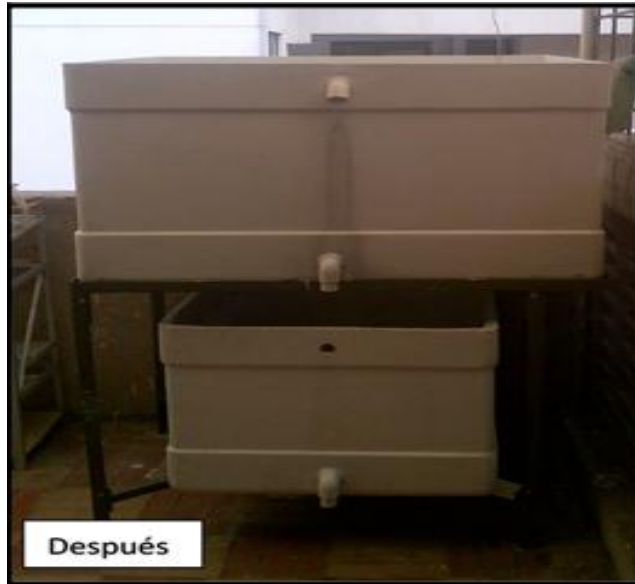
Ilustración 7. Sistema de almacenamiento de agua lluvia.
