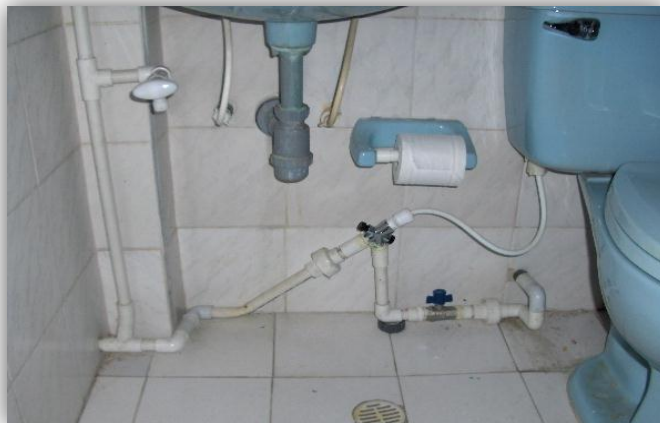
Ilustración 5. Sistema para el llenado el tanque con agua potable o agua tratada
