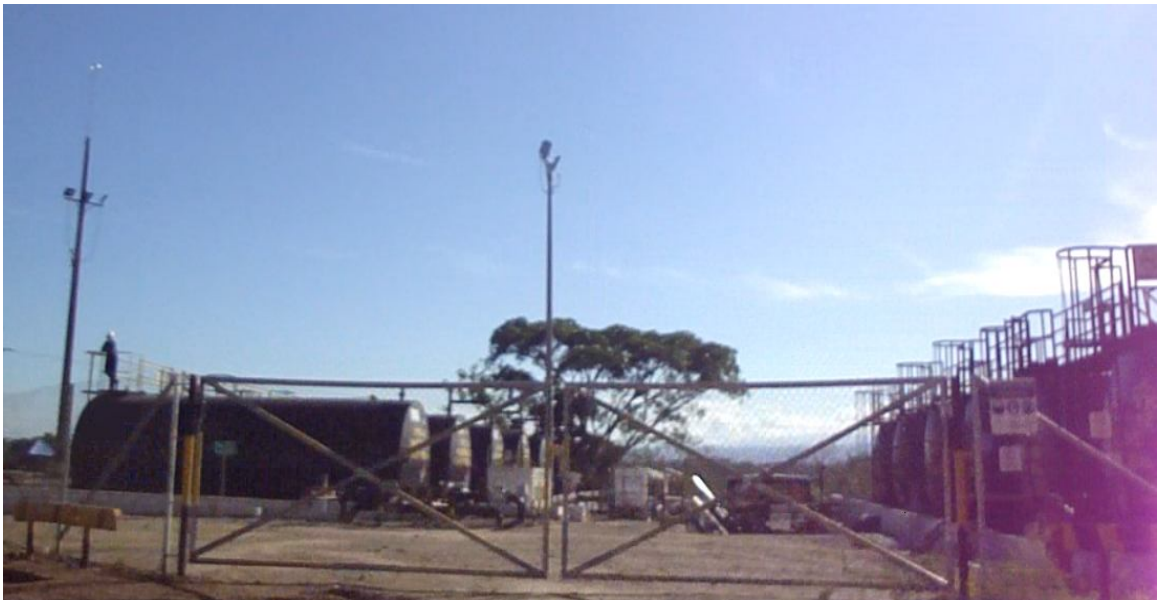
Figura 19. Tanques de Almacenamiento
