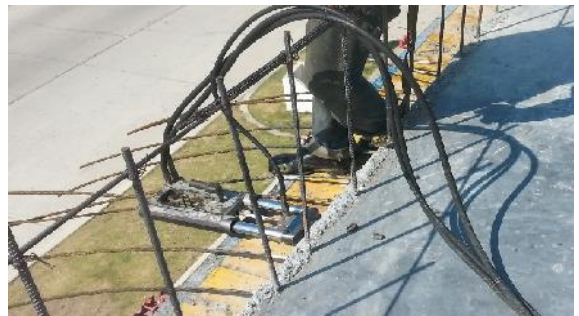
Imagen 5 , tensionamiento de los cables. Fuente: E. Vargas
