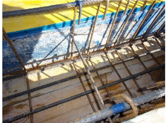
Imagen 2 28 , se muestra la varilla del perfil en viga. Fuente: E. Vargas
