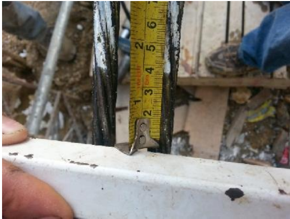
Imagen 6 , medición de la elongación de un torón luego de ser tensionado mediante una marca base.
