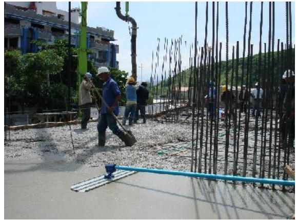
Imagen 4 , proceso de vaciado de concreto en placa. Fuente: E. Vargas
