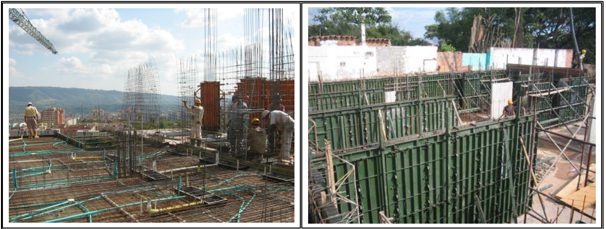
Figura No. 34. Encofrado metálico (Izq. Montaje en la placa de la estructura, acero y tubería, Der. Conformación de muros para fundir)
