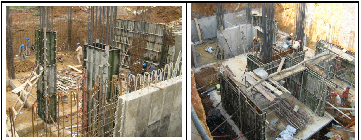
Figura No. 35. Encofrado metálico (columnas y muros de contención)
