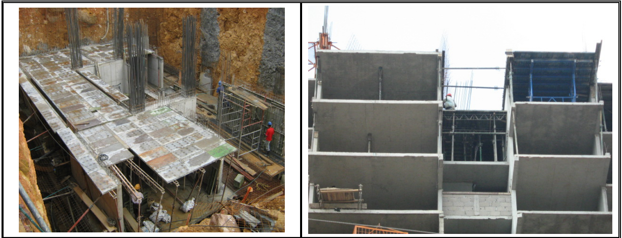
Figura No. 37. Acabados en la estructura (Módulos de apartamentos)
