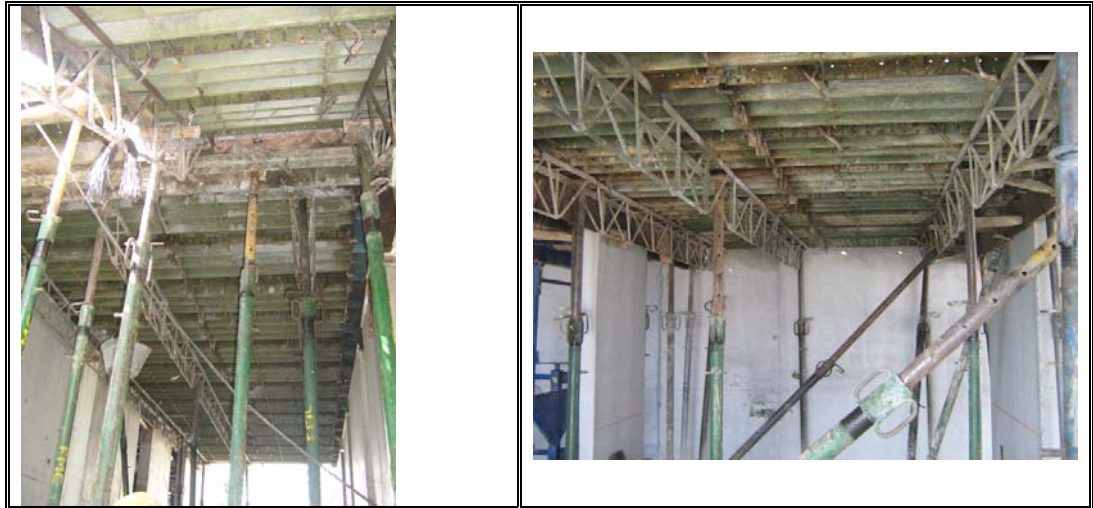
Figura No. 23. Utilización de Parales (Conformación de encofrado para la fundición de una placa)
