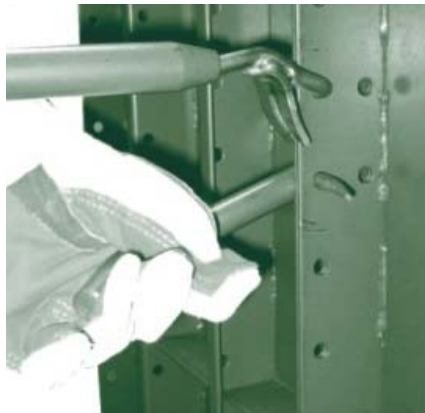
Figura No. 4. Bandas Laterales (modo de asegurar dos tableros)
