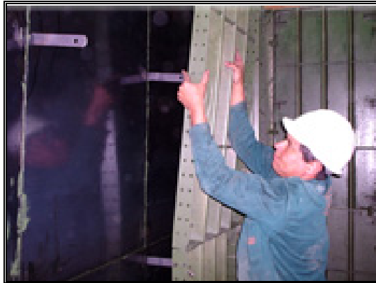
Figura No. 19. Instalación del Tablero con la ayuda de la corbatas y distanciadores
