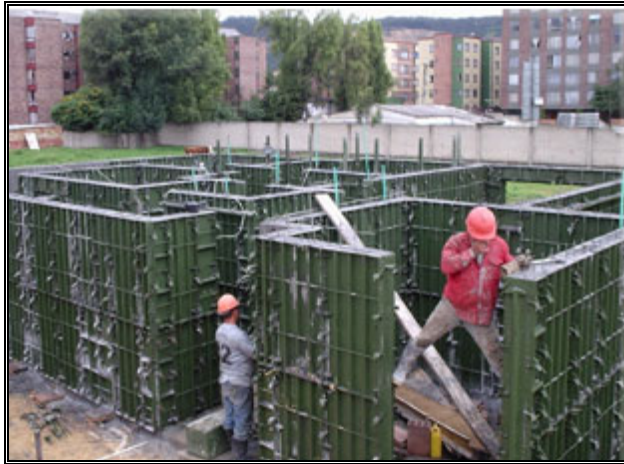
Figura No. 21. Encofrado Metálico (Módulos para vivienda)
