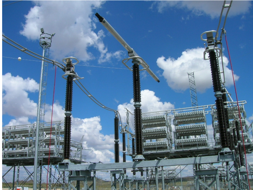
Figura 2.1.: Seccionador de cuchillas giratorias de tres columnas. [5]
