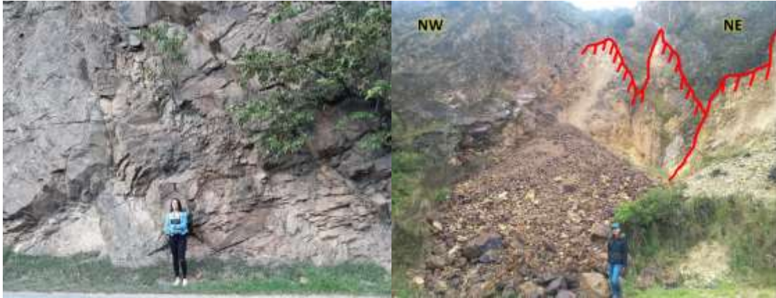
Figura 11. a) Afloramiento rocoso de la unidad Granito de pescadero. b) Movimiento de masa de tipo Caída de rocas ubicado a corte de carretera en la Vía Vetás - California.
