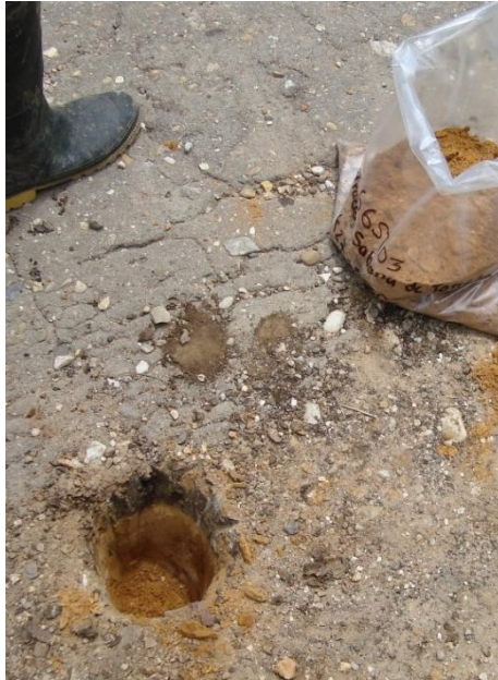
Ilustración 6. Apiques para determinación de espesores de las capas y características del pavimento. Extracción de muestras de subrasante. Información Geomática.
