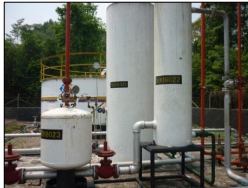
Figura 11. Separadores Bifásicos de la estación Campo Escuela Colorado.
