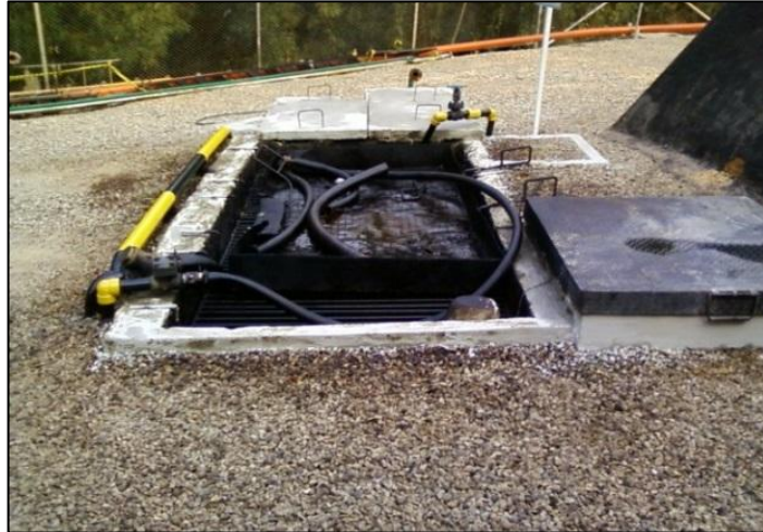
Figura 27. Trampa API para recolección de Aguas contaminadas con hidrocarburo del área de almacenamiento de crudo del Campo Escuela Colorado.
