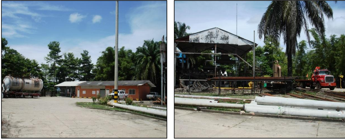
Figura 6. Vista Área antigua de Compresor y área de oficinas.
