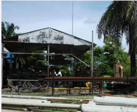
Vista del área antigua de compresión. Se encuentra sin uso y material en proceso de deterioro y corrosión.
