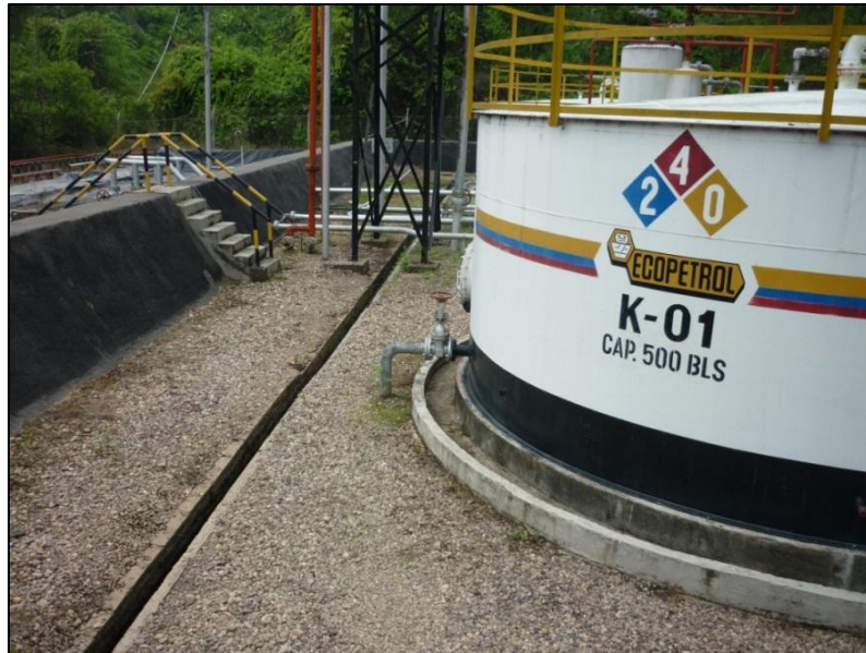
Figura 59. Visualización de barreras y bordillos de contención para el control de derrame en Campos Escuela Colorado.
