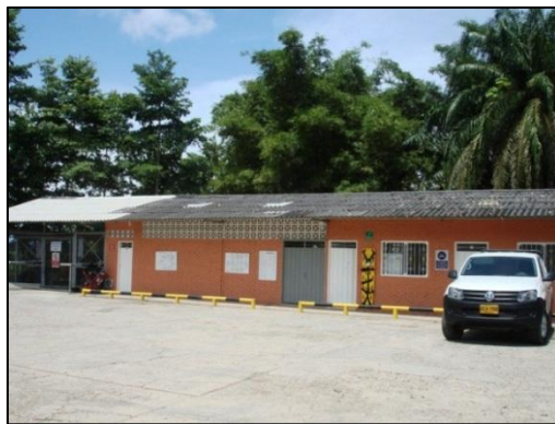
Figura 23. Oficinas de planta del Campo Escuela Colorado. Área de Servicios.
