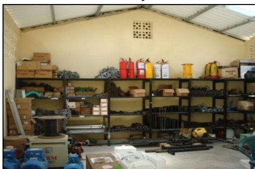
Figura 58. Medios de Extinción en Campo Escuela.
