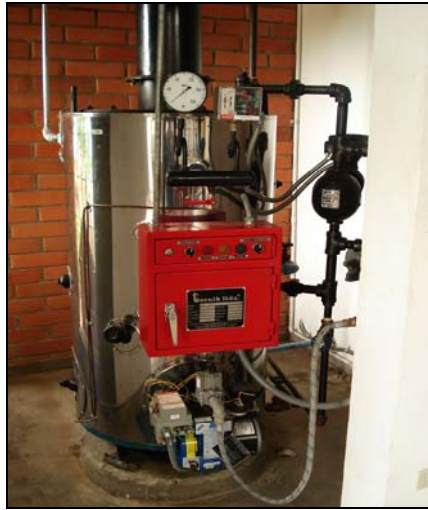
Figura 13. Caldera que utiliza un quemador a gas natural
