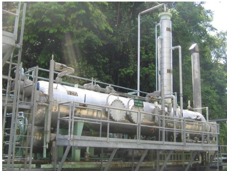
FOTOGRAFIA 2. TREN DE GLICOL DE LA PLANTA DE GAS EL CENTRO
