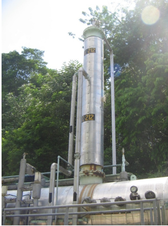
FOTOGRAFIA 3. TORRE C212 E INTERCAMBIADOR E212
