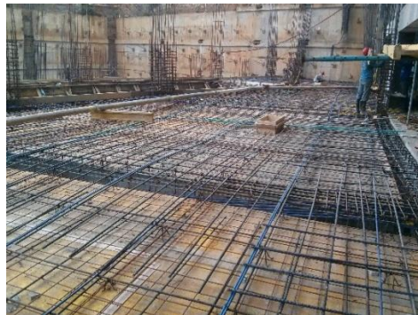
Figura 24. Colocación del postensado en los sótanos de Green Gold
