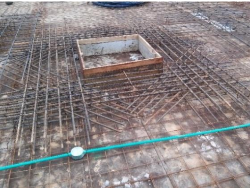
Figura 22. Detalle típico de abertura de losas
