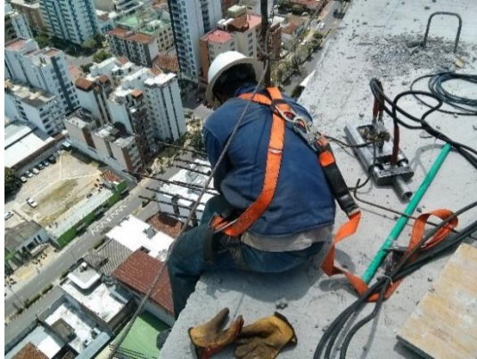
Figura 26. Supervisión realiza al tensionamiento del piso 39 de Green Gold
