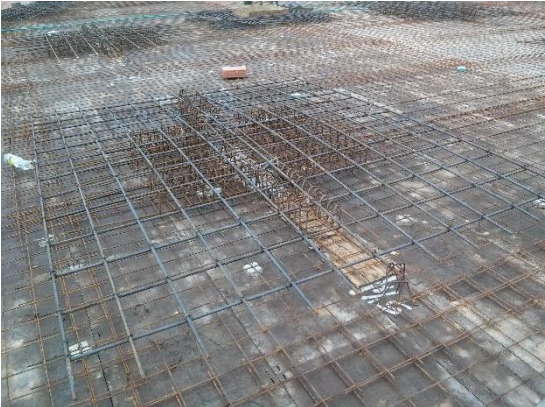
Figura 21. Detalle de refuerzo a flexión y punzonamiento
