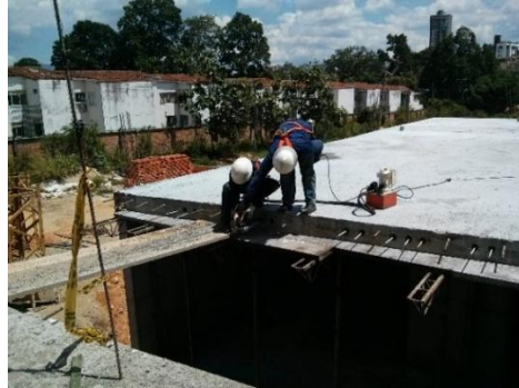
Figura 23. Proceso de tensionamiento
