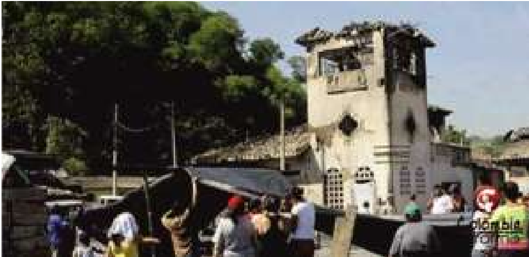
Figura 3. Día siguiente al incendio.
