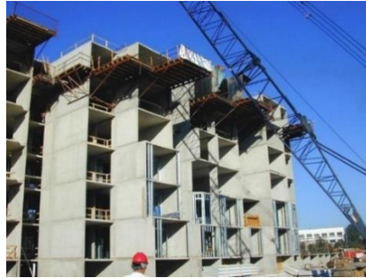
Figura 3 Retiro de formaleta mediante equipos
