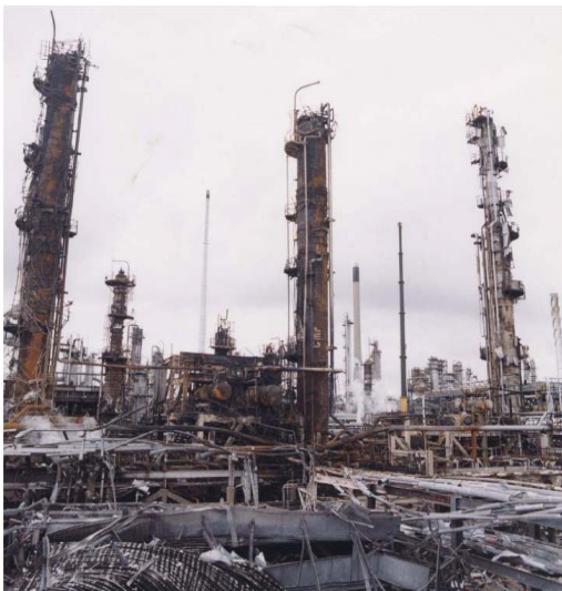
Figura 5a. Degradación de equipos de refinería por corrosión a alta temperatura.
