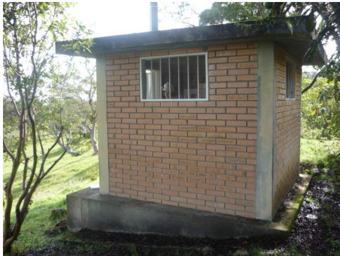
Rectificador Puente Nacional
