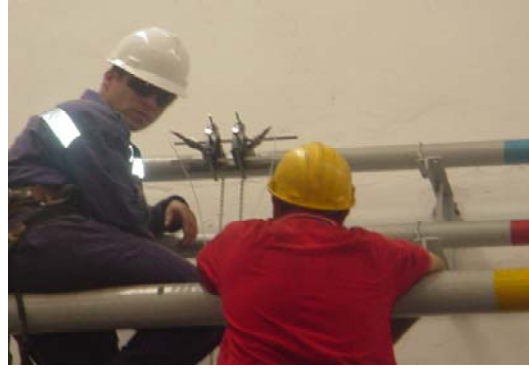
Línea de agua fría Horno, generador, secador de aire, rectificadoras cincinnati, excell-o y SI-4A
