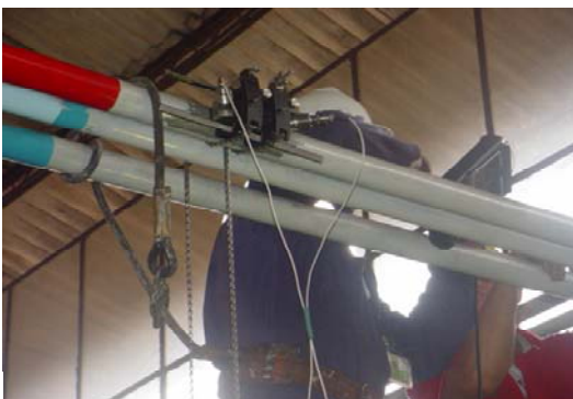
Línea de agua caliente de la máquina de temple FDF
