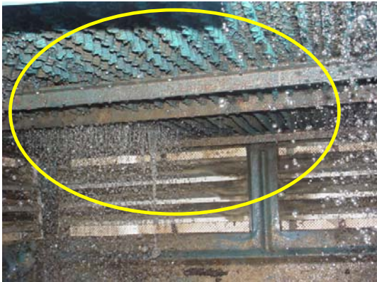
c. Vista de la distribución del agua
