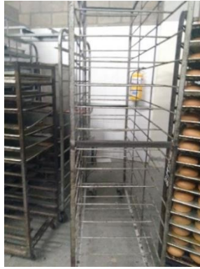
Figura 11 Extintor obstaculizado por torres Adaptado de planta centro abastos.
