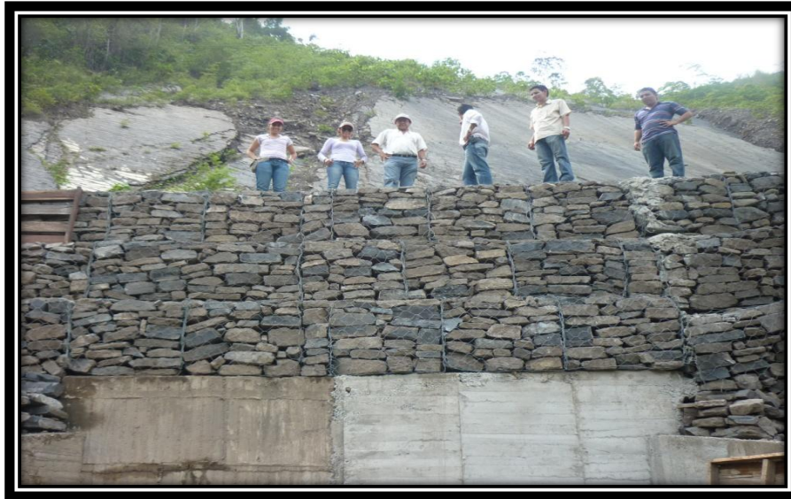
Fotografía No. 4. Revisión de Muro en Gaviones sobre box culvert. Fuente Torres Ing
