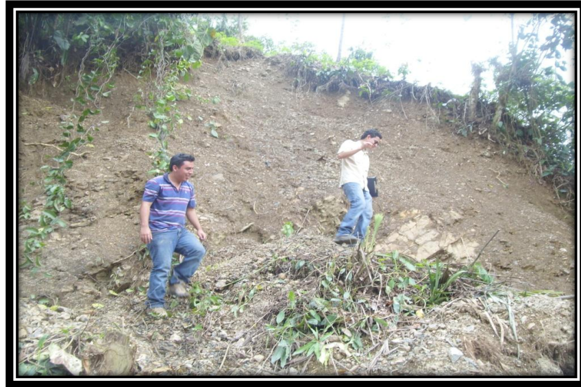
Fotografía No. 5. Visita de Campo al corredor vial, inspección de materiales sobre taludes. Fuente el autor
