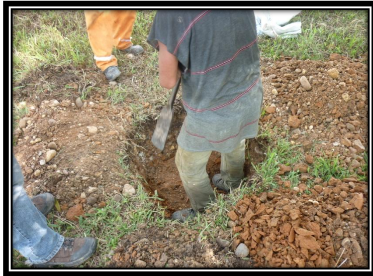
Fotografía No. 13 Paso 1 para obtención de muestras inalteradas - Fuente Torres Ing
