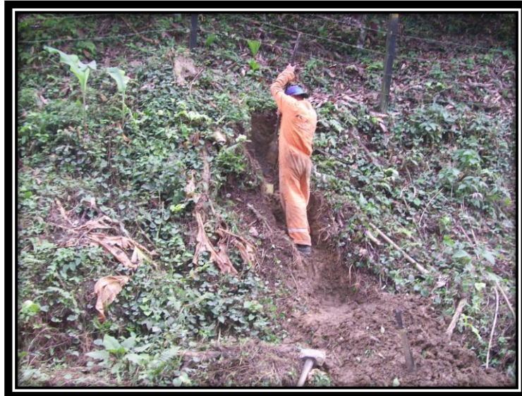
Fotografía No. 12 Trinchera para obtención de muestra - Fuente Torres Ing
