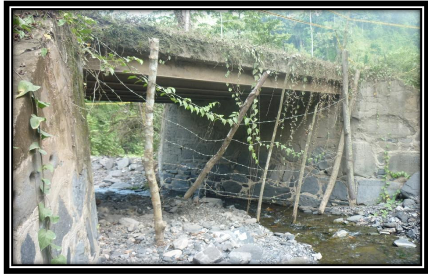
Fotografía No. 3. Puente k53+235 vía hacia Landázuri. Fuente Torres Ing.
