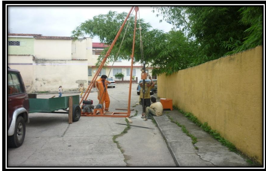
Fotografía No. 10. Barrio Villa Esmeralda, equipo de perforación. Fuente Torres Ing
