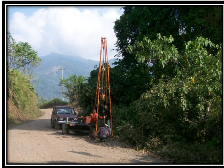
Fotografía No. 17 Perforación sobre la banca de la vía.
