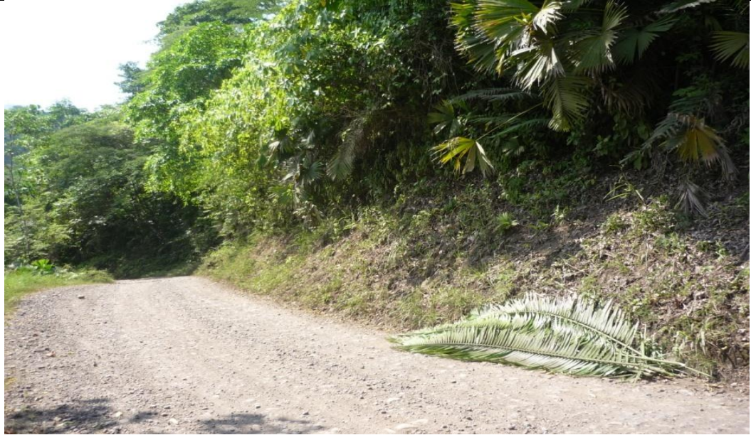
Descripción: Talud estado actual PR 41+800,
