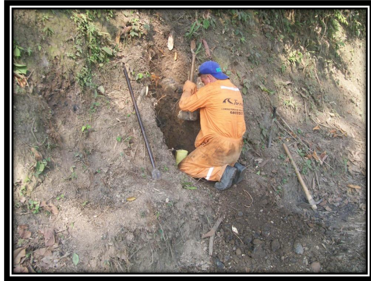
Fotografía No. 6. Trinchera sobre el talud interior de la vía, kilometro K39+840. Fuente Torres Ing
