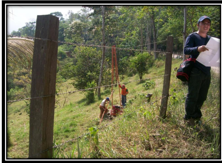
Fotografía No. 2. Sondeo número uno en el costado exterior de la vía. Fuente Torres Ing
