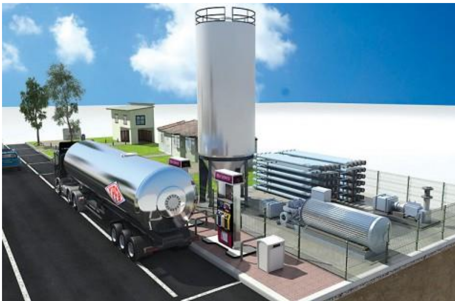
Figura 60. Planta satélite de regasificación.
