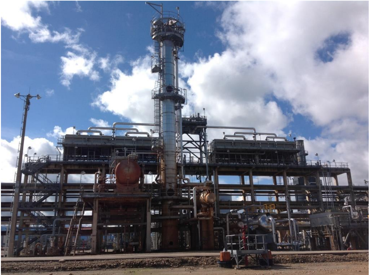
Figura 10. Torre de-butanizadora- Planta GLP Cusiana
