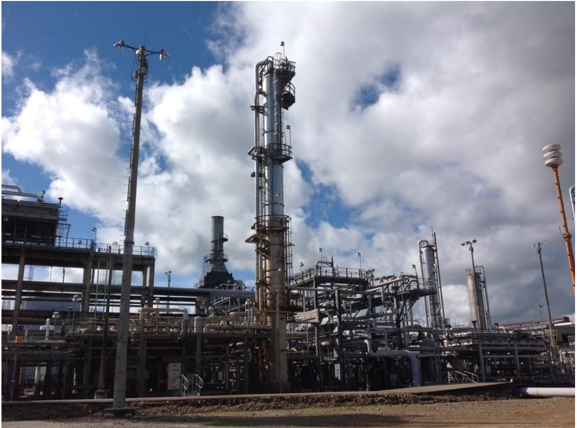
Figura 9. Torre de-etanizadora- Planta GLP Cusiana
