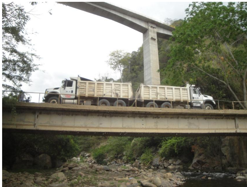
Figura 1. Prueba de carga – Puente el Ramo, vía La Renta – San Vicente de Chucurí, Santander.
