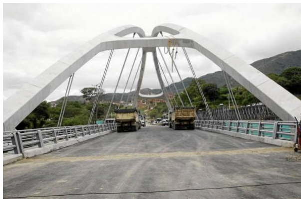
Figura 2. Prueba de carga al puente Flandes en Girón-Santander [4]
