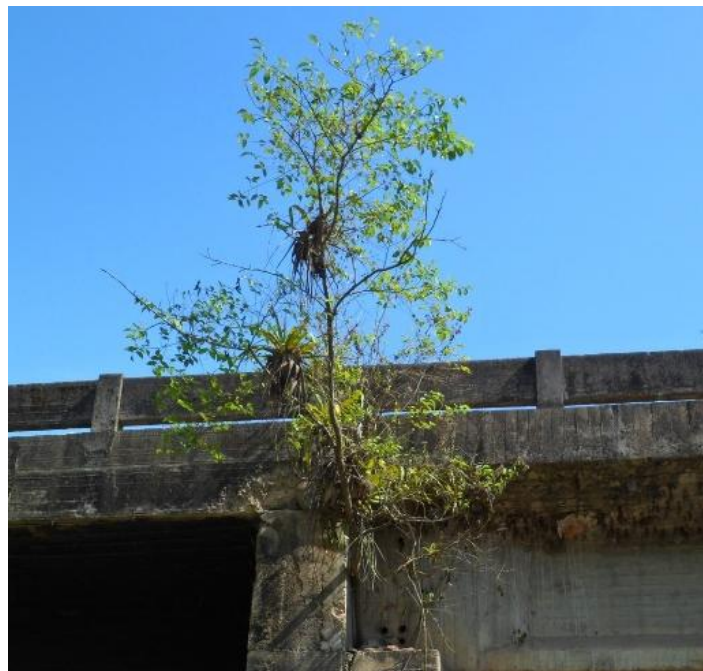
Figura 4. Fotografía de vegetación sobre el puente.
