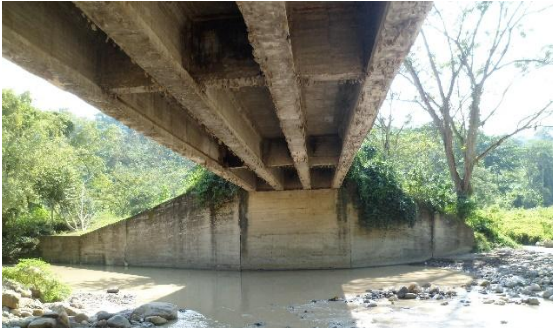
Figura 3. Vista inferior del puente Aguablanca
