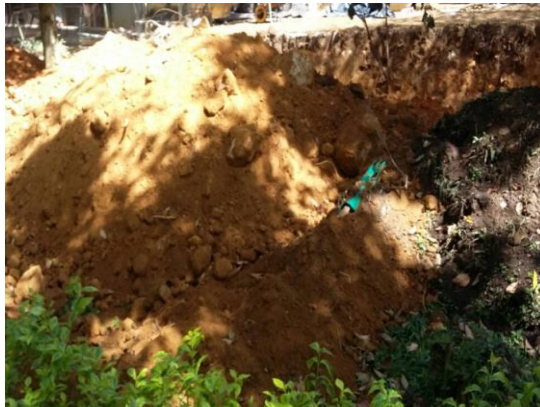
Figura 2. Suelo extraído de la excavación, Edificio de Ingeniería Mecánica.
