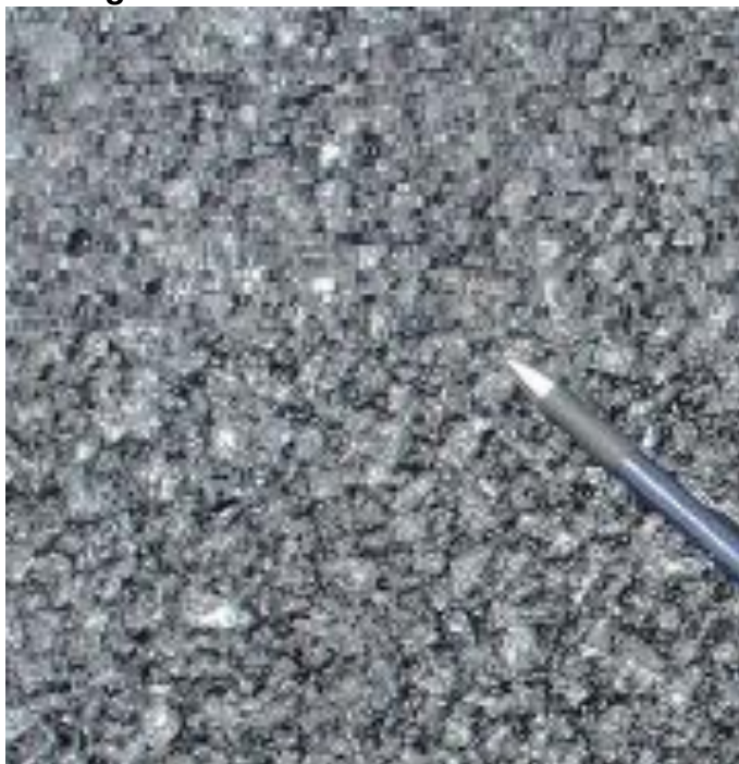
Figura 3. SMA construido en el terreno
