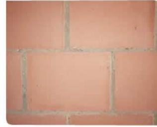
Figura 7. Bloque perforación vertical pared sencilla 11,5 x 23 x 33 y Bloque Perforación vertical pared sencilla medio 11,5 x 11 x 16
