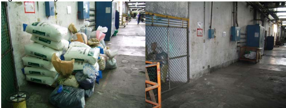
Figura 76. Fotografías del antes y después de la adecuación del cuarto de colorantes.
