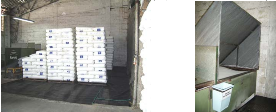
Figura 75. Disposición de tela cubre suelos y tapas de tolvas en la minibodega
