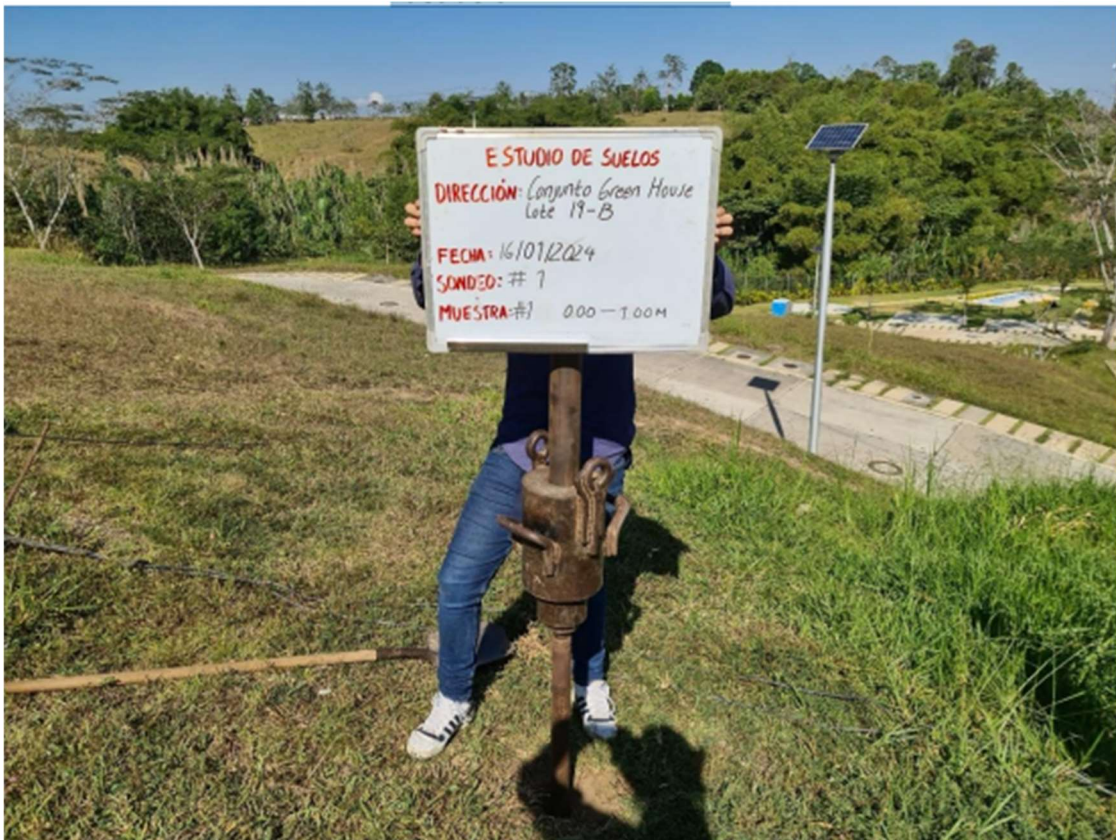
Ilustración 7: Ensayo in situ para estudio de suelos lote 1: 19B
