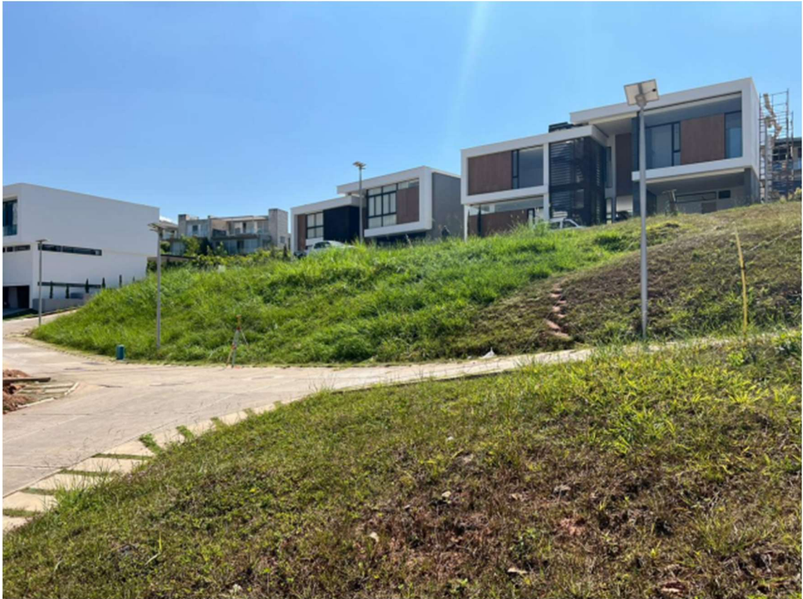
Ilustración 9: Fotografía 2, lote 1: 19B
