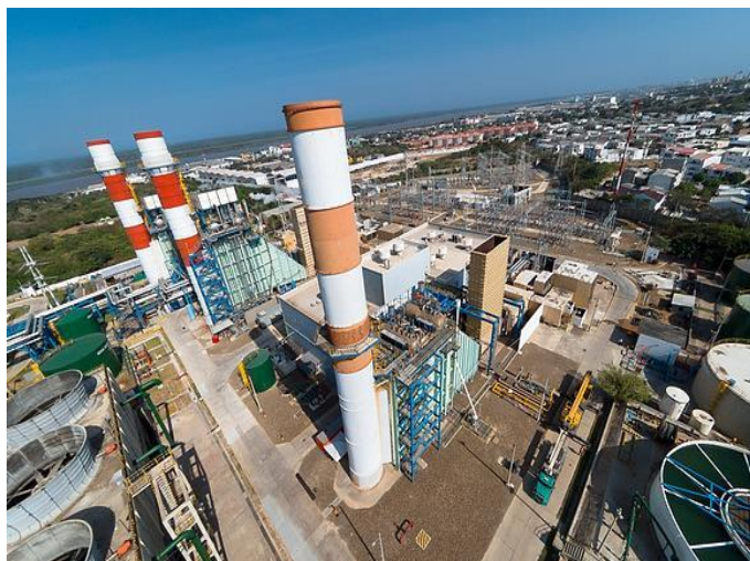
Figura 19. Instalaciones de Termoflores [503].
