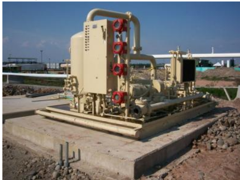
Figura 10. Unidad Recuperadora de Vapor (URV)
