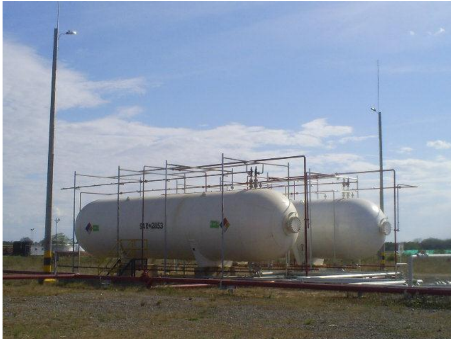
Figura 15. Balas de almacenamiento de GLP
