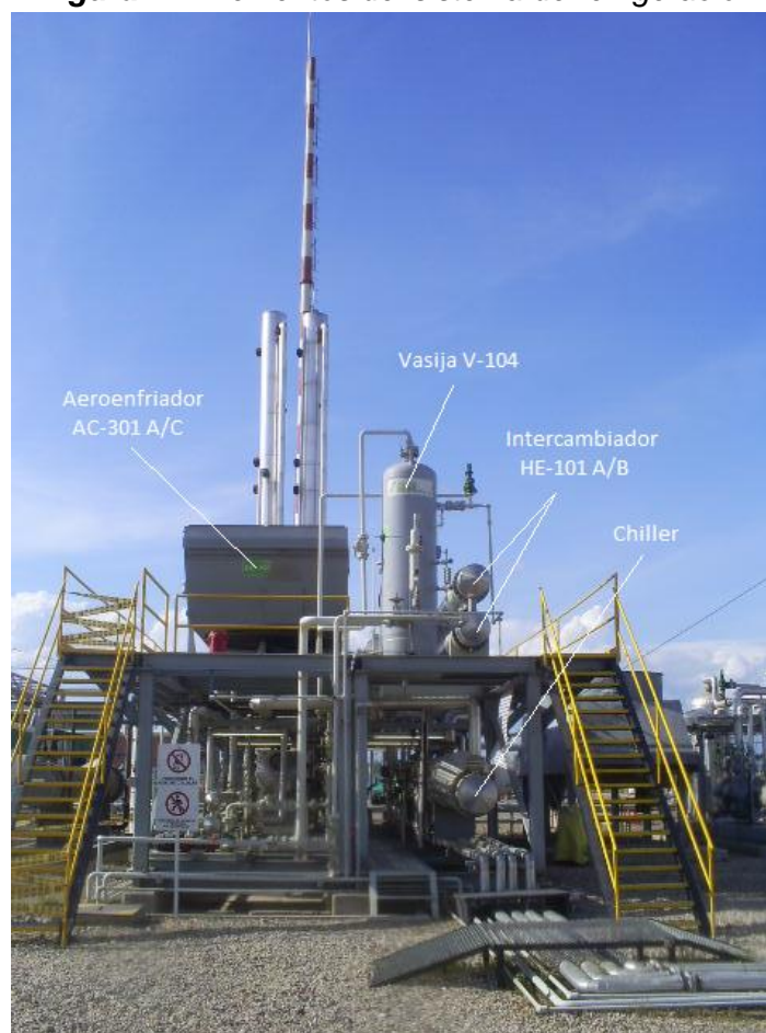
Figura 12. Elementos del sistema de refrigeración
