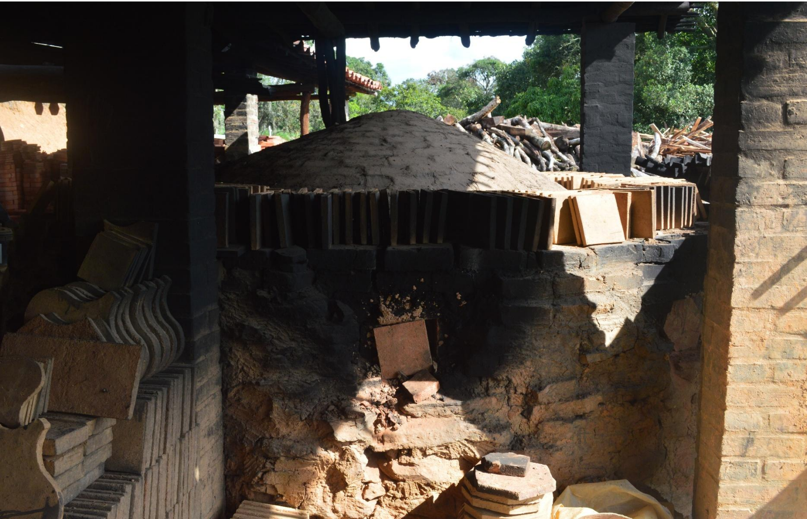
Ventanilla de un horno en listo para entrar en funcionamiento tapada con toletes y tablonés
