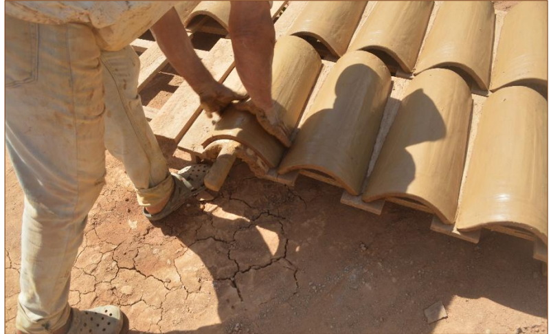
Desmante de la teja del galápago al sol
