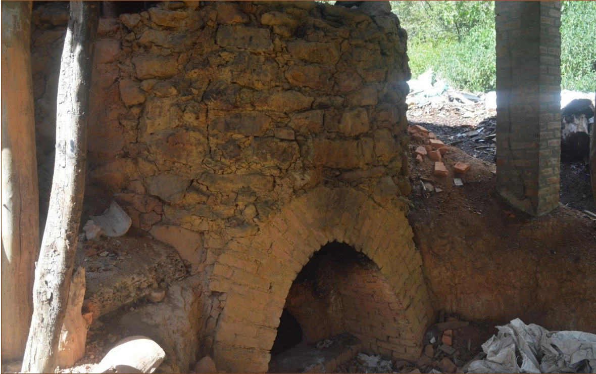
Parte posterior de un horno tradicional por fuera, por donde se ingresa el cabrón y la leña
