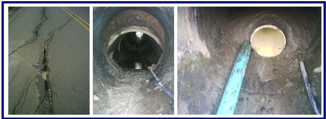
Fig. 9 Reparación Alcantarilla PR 61 + 850
