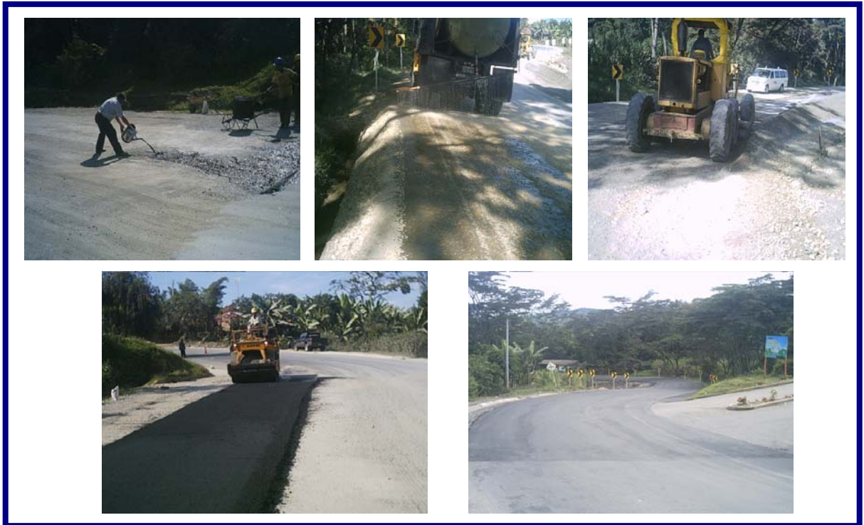
Fig. 16 Colocación Carpeta Asfáltica Ramal a Chitaraque
