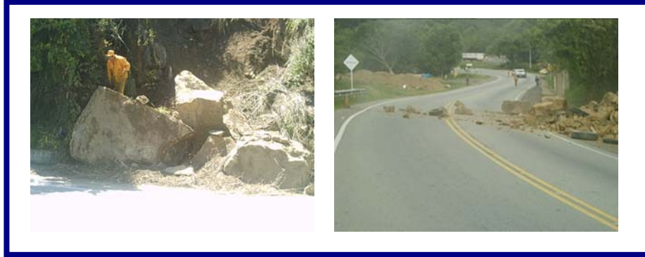
Fig. 7 Demolición y remoción de derrumbe.
