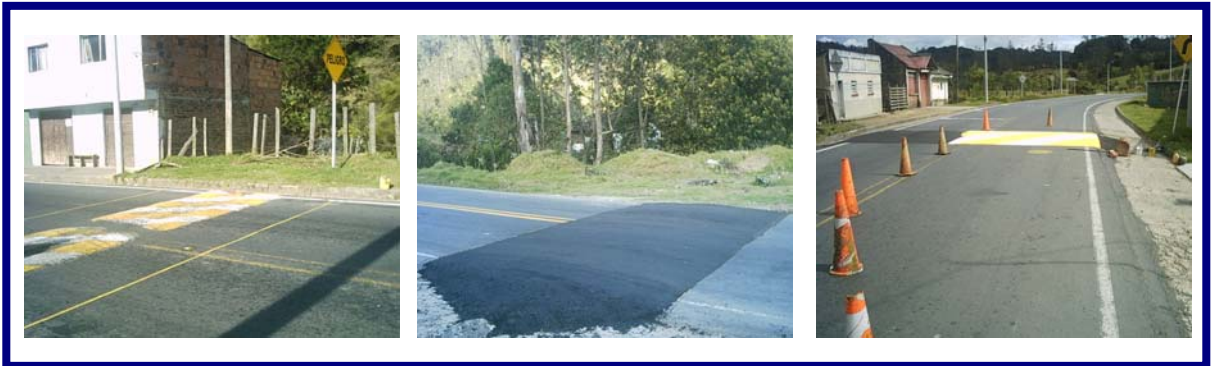
Fig. 5 Construcción de Resaltos
