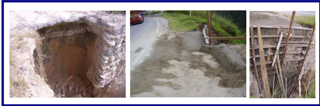
Fig. 14 Muro de Estabilización
