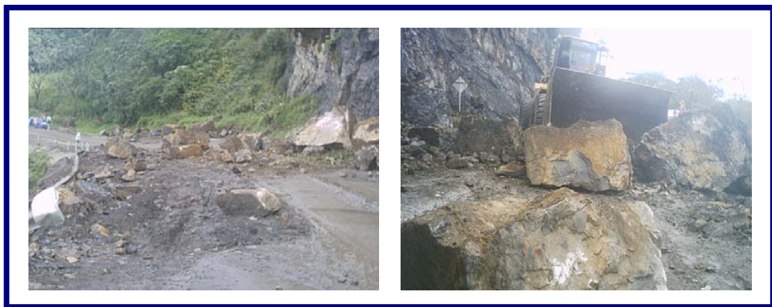
Fig. 10 Remoción de Derrumbe en el Teherán
