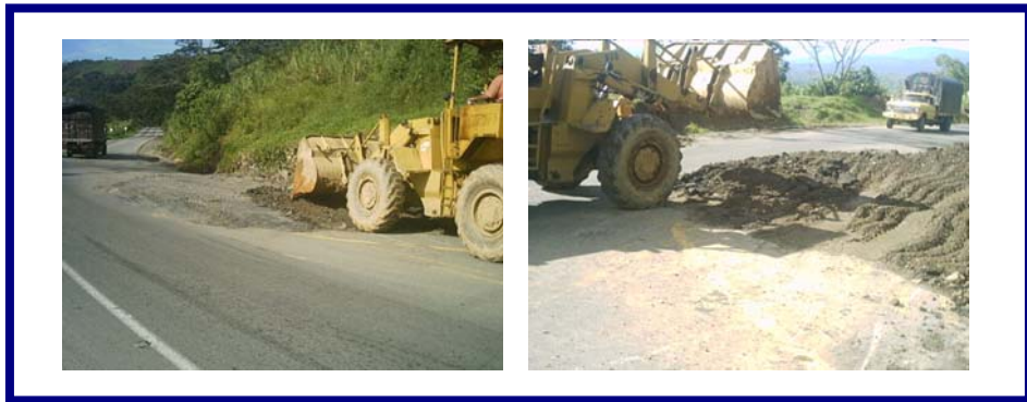
Fig. 8 Renivelación Paso La Preñada
