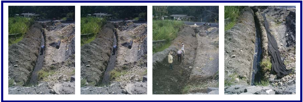
Fig. 17 Construcción Filtro
