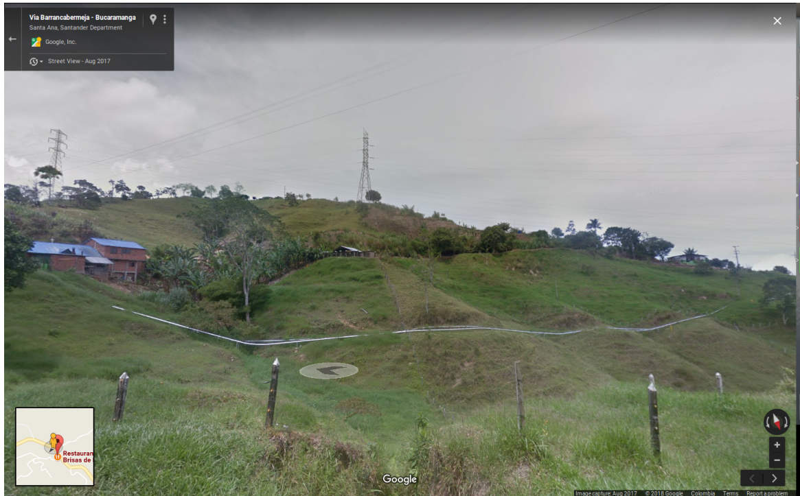
Figura 3. Oleoducto (gris claro) con inclinación considerable, vía Bucaramanga - Barrancabermeja, a la altura de Brisas de México, Coordenadas (7.144967, -73.272821) - Imagen de Google Street View.
