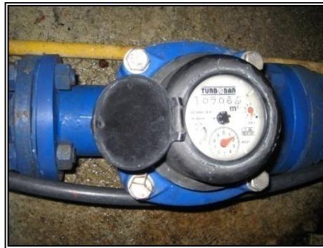
Imagen 21. Macromedidor Planta De Tratamiento
