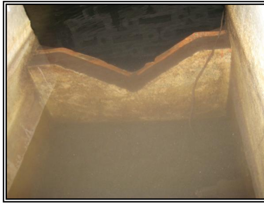
Imagen 17. Exceso De Agua En La Medición Del Caudal
