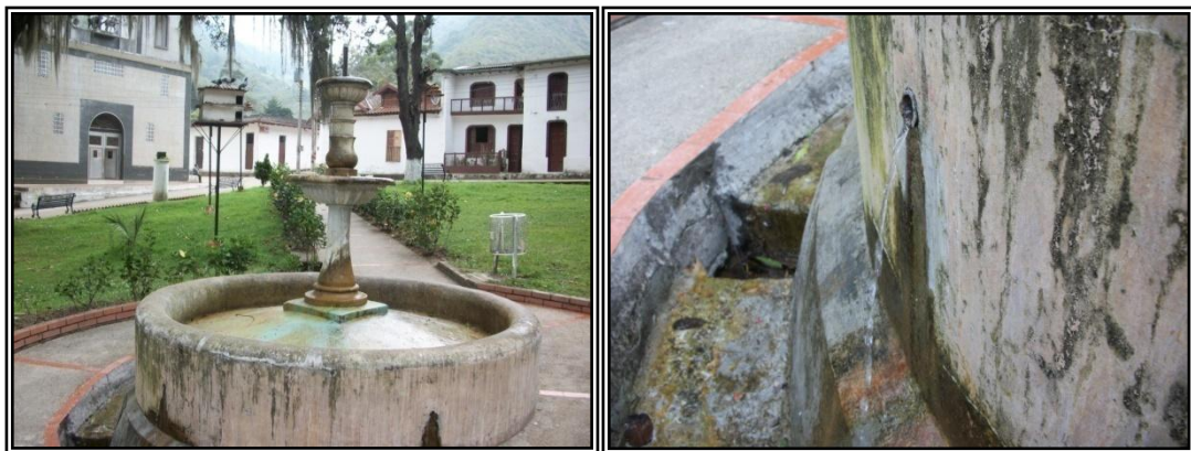
Imagen 23. Conexión Fraudulenta Del Parque Principal
