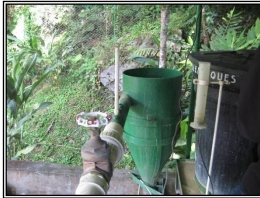
Imagen 40. Válvula Reguladora Para Planta De Tratamiento
