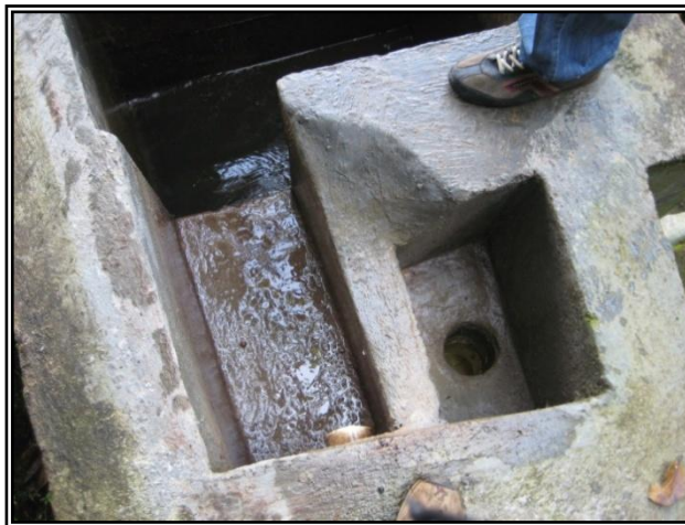
Imagen 10. Estructura De Entrada Al Desarenador Alto Tomasa
