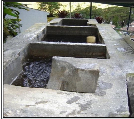
Imagen 8. Desarenador Alto Tomasa
