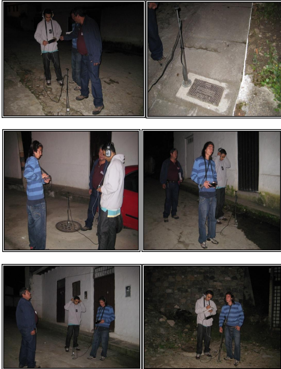
Imagen 22. Identificación De Fugas Mediante Geófono
