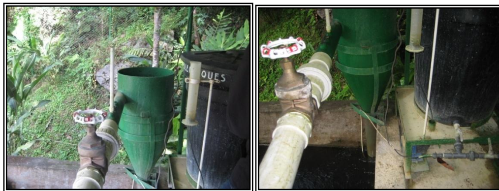
Imagen 18. Mala Dosificación Del Sulfato De Aluminio
