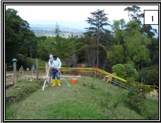
Figura 48. Localización de puntos a perforar
