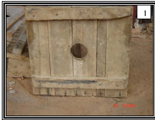
Figura 44. Elaboración y colocación de formaleta
