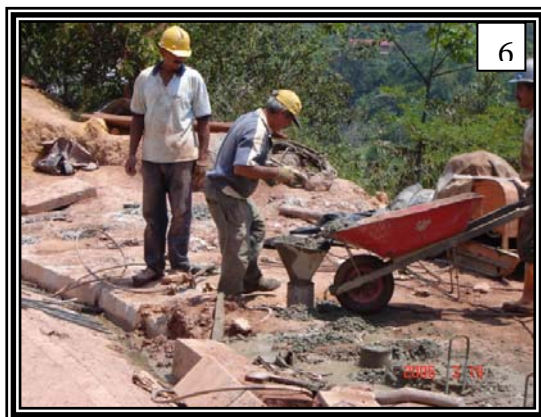
6. Cuando los pilotes están a nivel del terreno el vaciado se hace directamente desde la carreta. Para esto también se utiliza el embudo metálico con el fin de disminuir los desperdicios de concreto.
