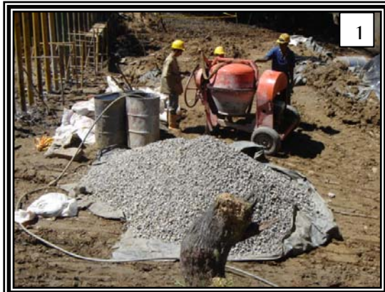
Figura 27. Preparación del Concreto
