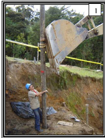
1. Izando pilotes con ayuda de la retroexcavadora
