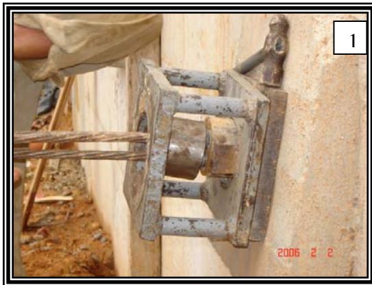
Figura 47. Tensionamiento
