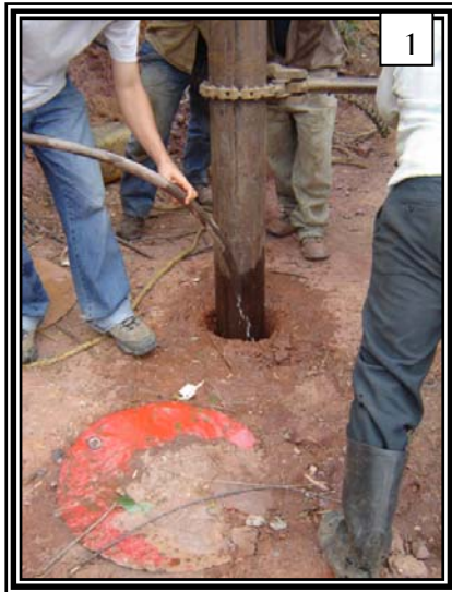
Figura 21. Repaso de Perforación
