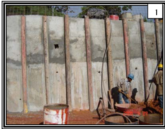
Figura 29. Localización de puntos a perforar
