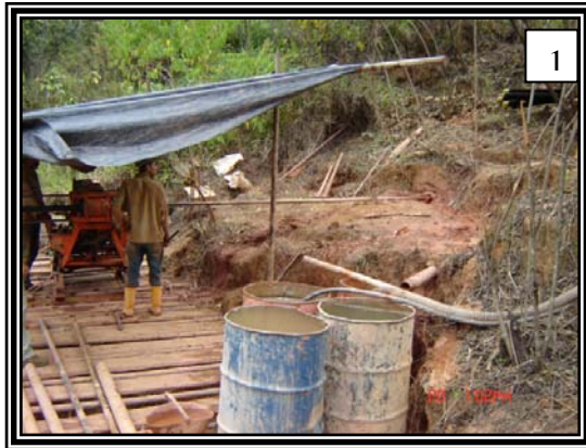
Figura 54. Construcción de Piscina de lodos
