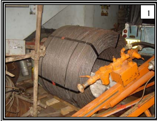
Figura 40. Elaboración de anclajes.
