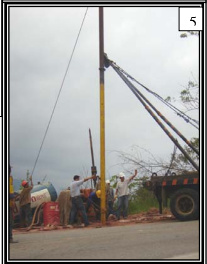
4. Izado de pilotes con ayuda de una grúa, se observa a dos personas guiando la punta del pilote.
