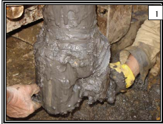
Figura 20. Cambio de Brocas
