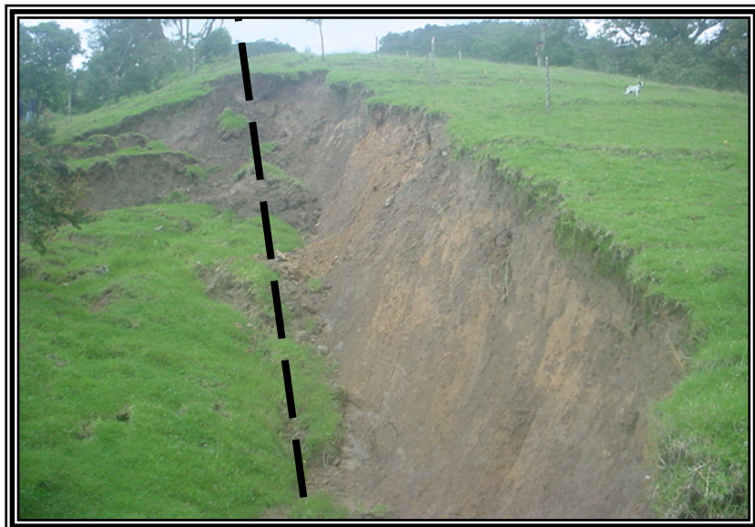
Figura 2. Deslizamiento de tierra
