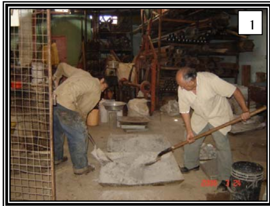
Figura 45. Preparación del concreto
