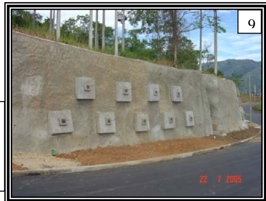
9. Detalle de anclajes tensionados sobre un talud recubierto en concreto lanzado.
