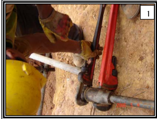
Figura 50. Instalación elementos del eje de perforación
