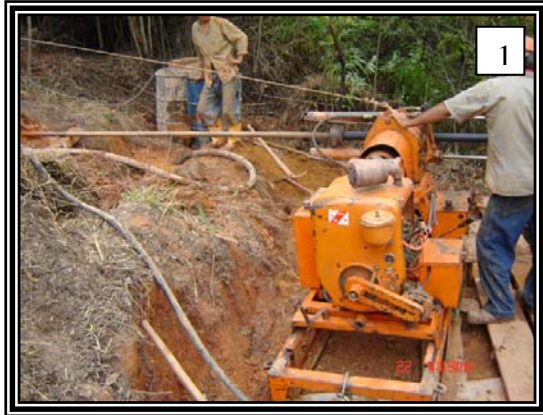
Figura 56. Procedimiento para perforar
