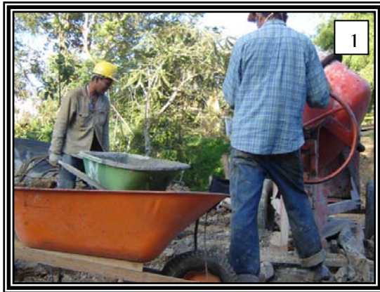
Figura 28. Vaciado del Concreto
