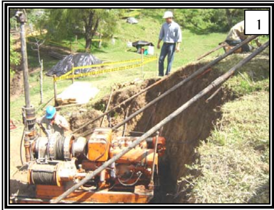
Figura 13. Instalación torre metálica
