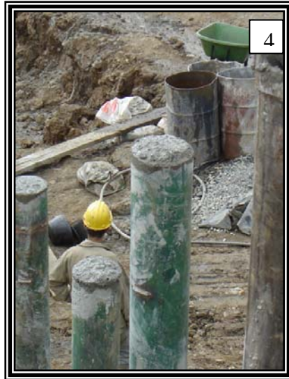
4. Detalle de los pilotes fundidos.
