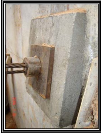
Figura 9. Detalle de Anclaje *
