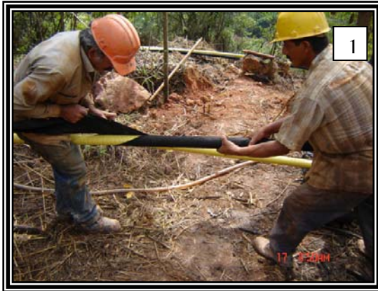
Figura 59. Revestimiento de tubería
