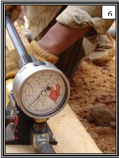
6. Detalle del manómetro de la bomba manual
