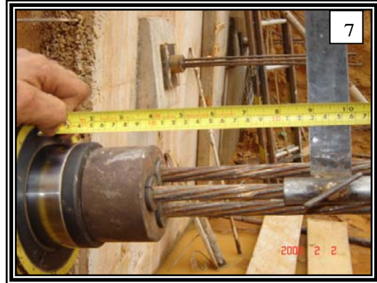
7. Se observa haciendo la respectiva medición de elongación del cable.
