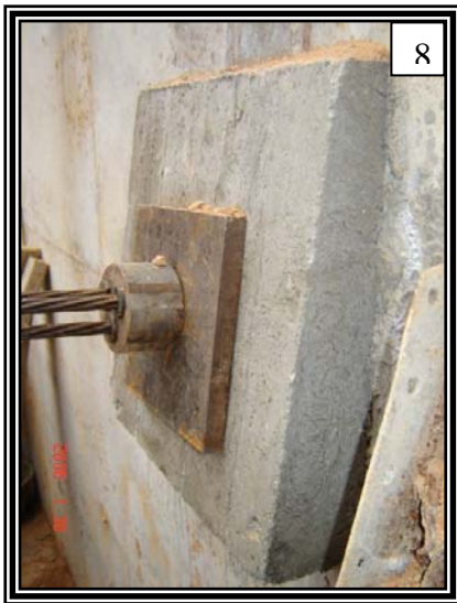
9. Detalle de anclajes tensionados sobre un talud recubierto en concreto lanzado.
