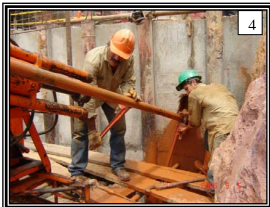
4. Se observa a los trabajadores soltando la tubería para cambio de brocas. Las llaves son de 36 pulg.
