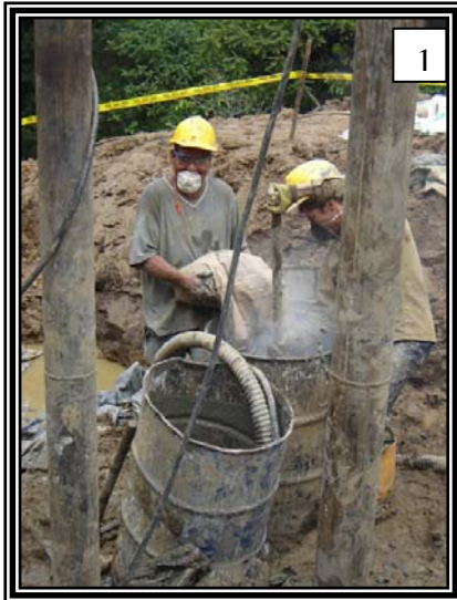
Figura 42. Preparación de la lechada
