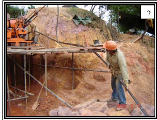
Figura 39. Acarreo interno y colocación de anclajes
