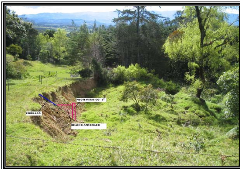
Figura 4. Obra de pilotaje terminada
