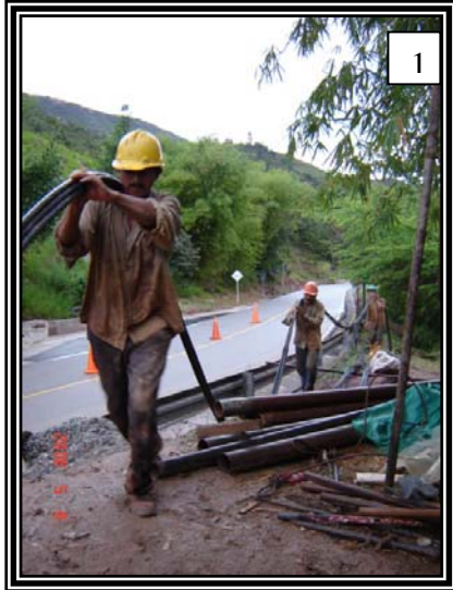
Figura 39. Acarreo interno y colocación de anclajes
