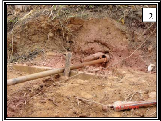
2. Detalle de la perforación. En este caso se utilizó tubería A.
