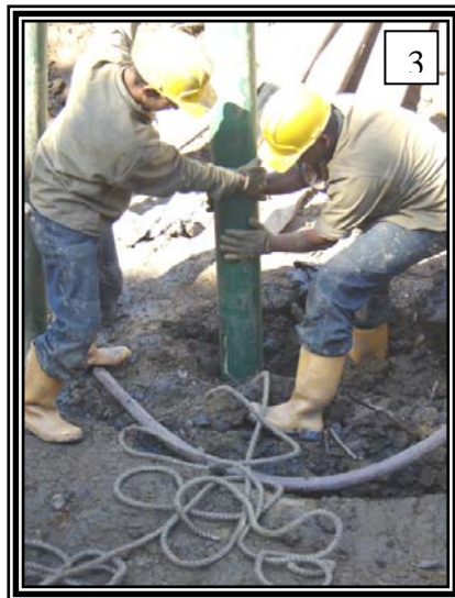
5. Colocado el pilote en posición vertical Se inicia su descenso lento en la perforación. Se puede también observar las personas que guían el pilote con ayuda de cuerdas desde la parte superior e inferior.
