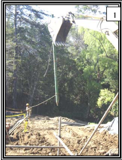
1. Traslado de pilote con ayuda de la retroexcavadora.
