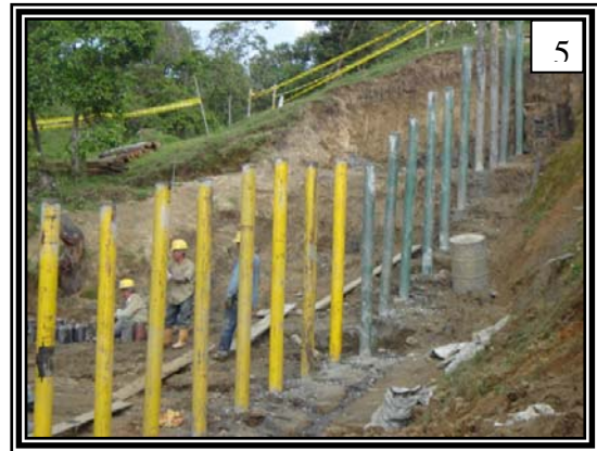
5. Hilera de pilotes ya fundidos.
