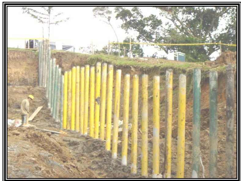
Figura 4. Obra de pilotaje terminada
