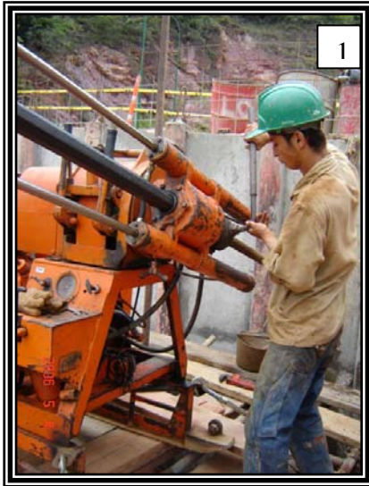
Figura 32. Graduación del cabezote del taladro
