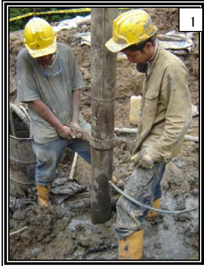
Figura 26. Inyección de lechada
