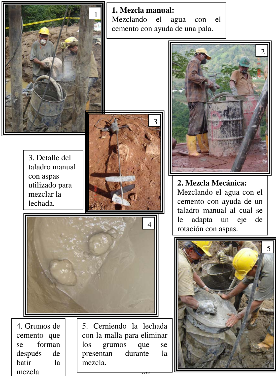
Figura 25. Preparación de lechada
