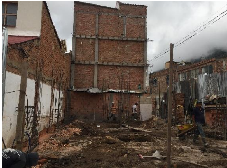
FIGURA 19. Inspecciones de Obra.
