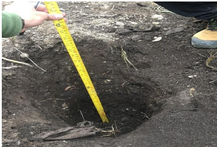
FIGURA 14: Prueba de Permeabilidad.
