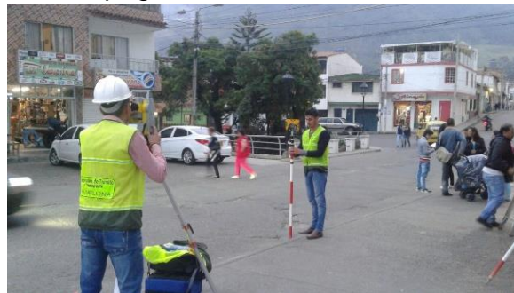
FIGURA 1. Levantamiento topográfico de la Calle 5
