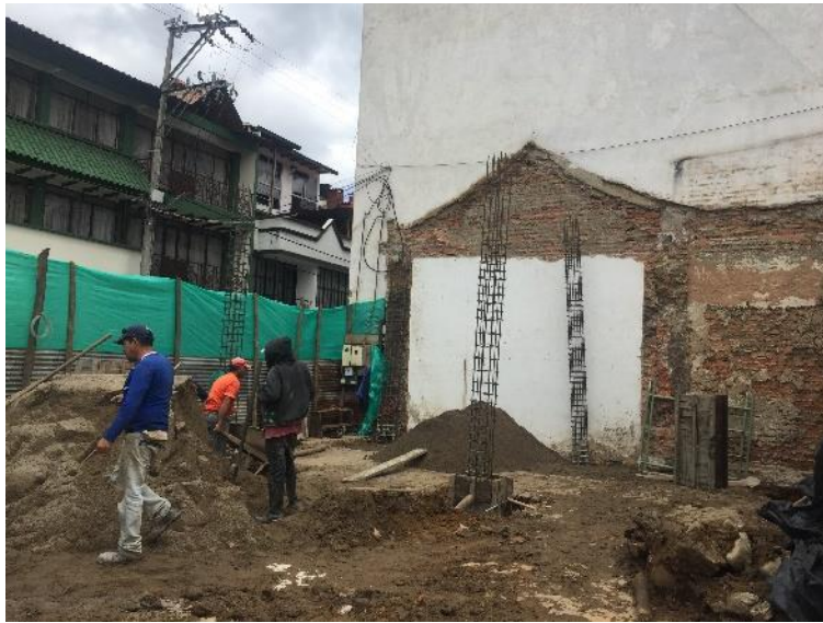
FIGURA 21. Inspecciones de Obra.
