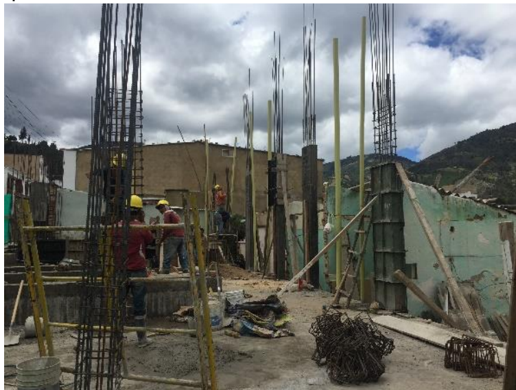
FIGURA 20. Inspecciones de Obra.
