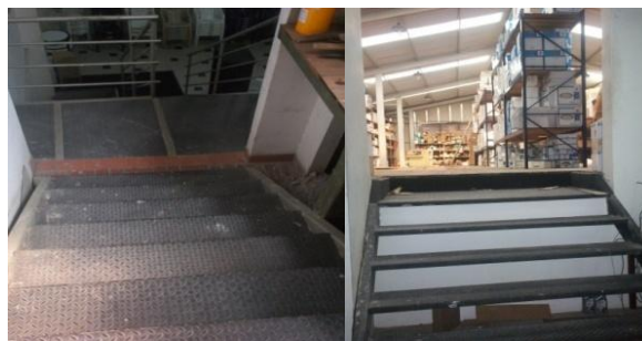
Figura 13. Escaleras de las bodegas
