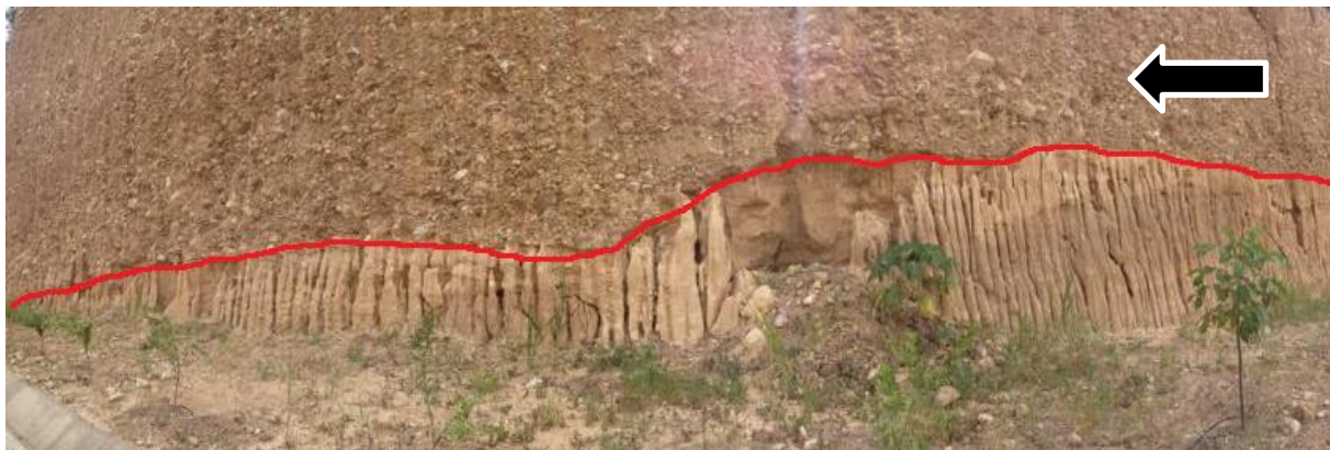
Figura 42. Contacto erosivo entre la Facie Arenosa (Sh) y la Facie de Arenas Matriz soportadas (Gms).
