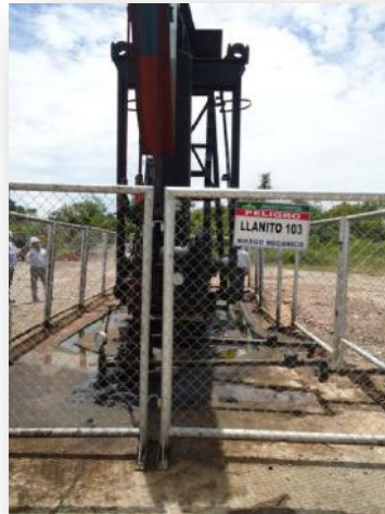
Figura 26. Unidades de Bombeo Mecánico Llanito 103
