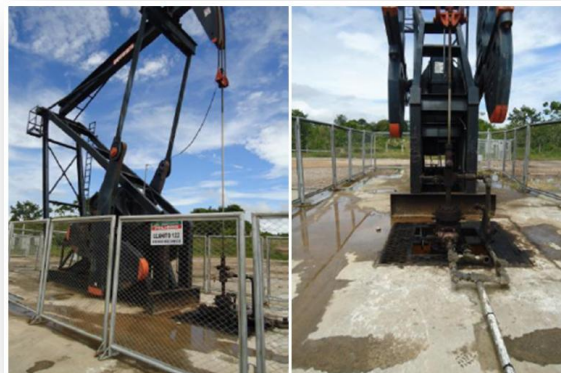
Figura 24. Unidades de Bombeo Mecánico Llanito 122
