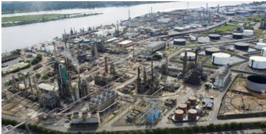
Figura 2. Refinería de Barrancabermeja.
