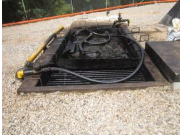
Figura 6. Piscina API Estación Campo Colorado.
