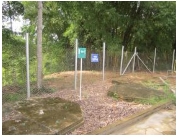
Foto 1. Pozos sépticos Campo Colorado
