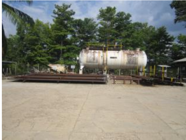
Figura 4. Vista General Antigua Planta Compresora.
